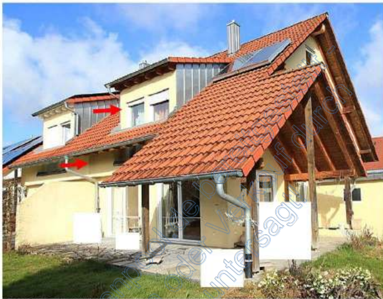
Gesamtes Doppelhaus von Nordwesten, Pfeile östliche Haushälfte ATP Nr. 1 mit Terrasse
