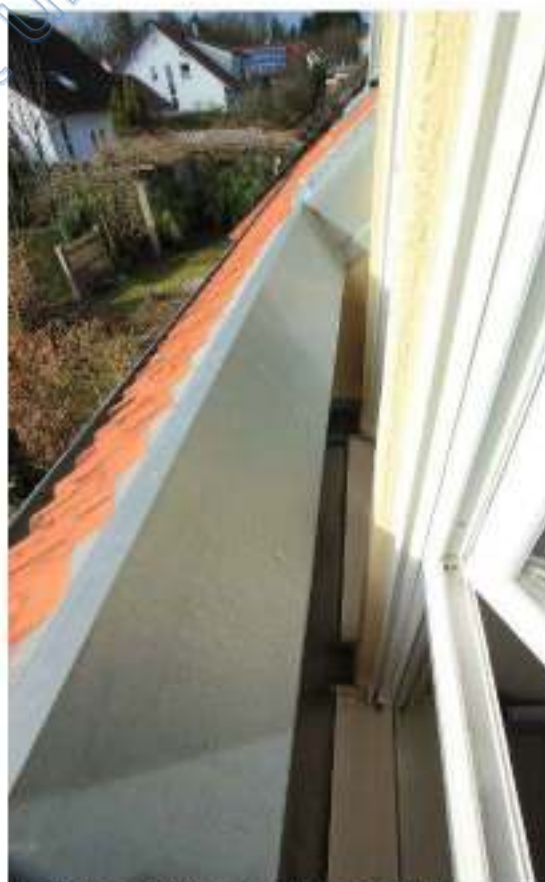
Dachkonstruktion vor dem Fenster
