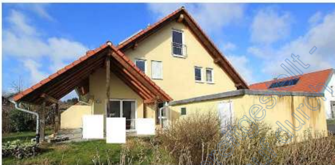
Ostseite der Haushälfte ATP Nr. 1 mit Terrassenüberdachung, rechts Doppelgarage
