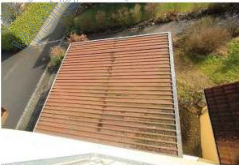
Blick hinunter auf das Garagendach
