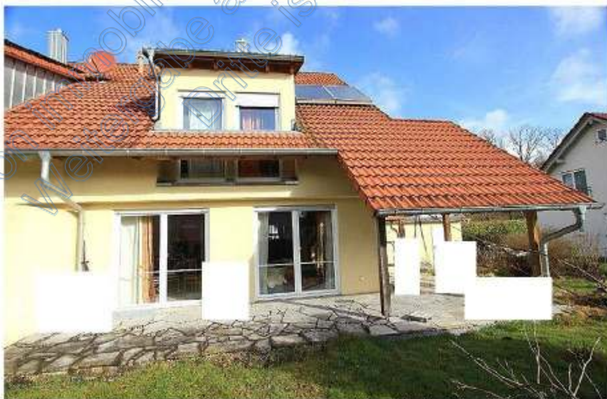
Südseite östliche Haushälfte ATP Nr. 1 mit Terrasse + flächenbündiger Terrassenüberdachung
