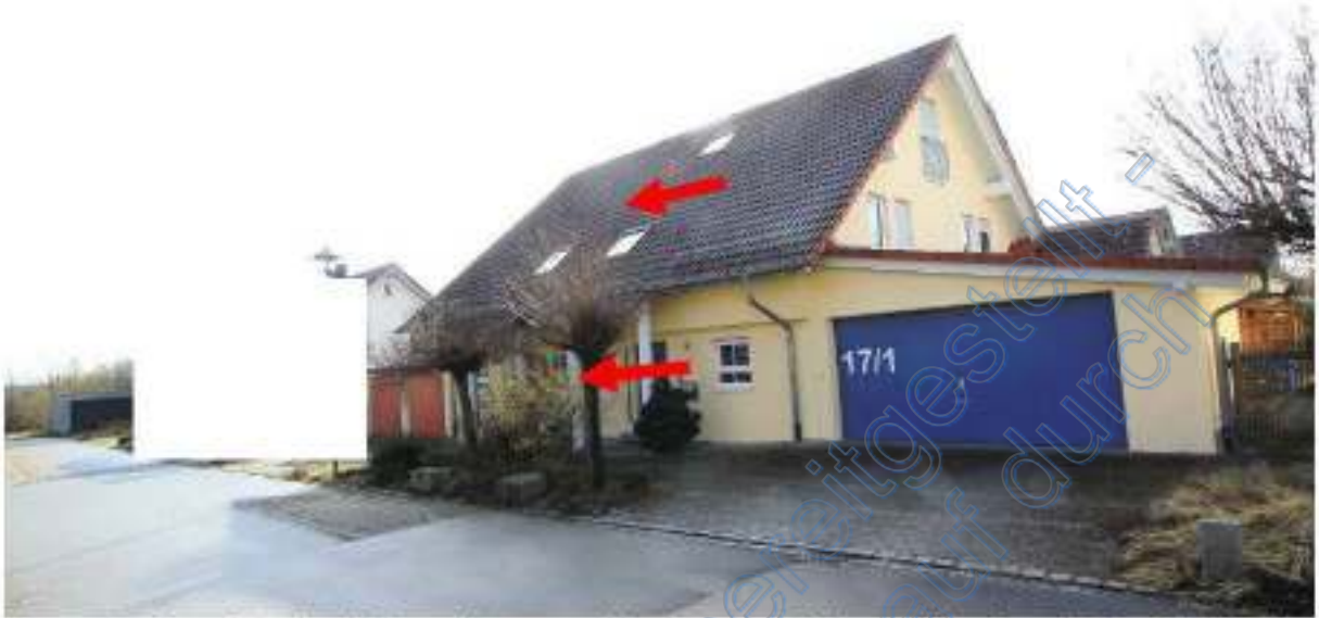
Gesamtes Grundstück mit Doppelhaus von Nordwesten, Pfeile östliche Haushälfte ATP Nr. 1
