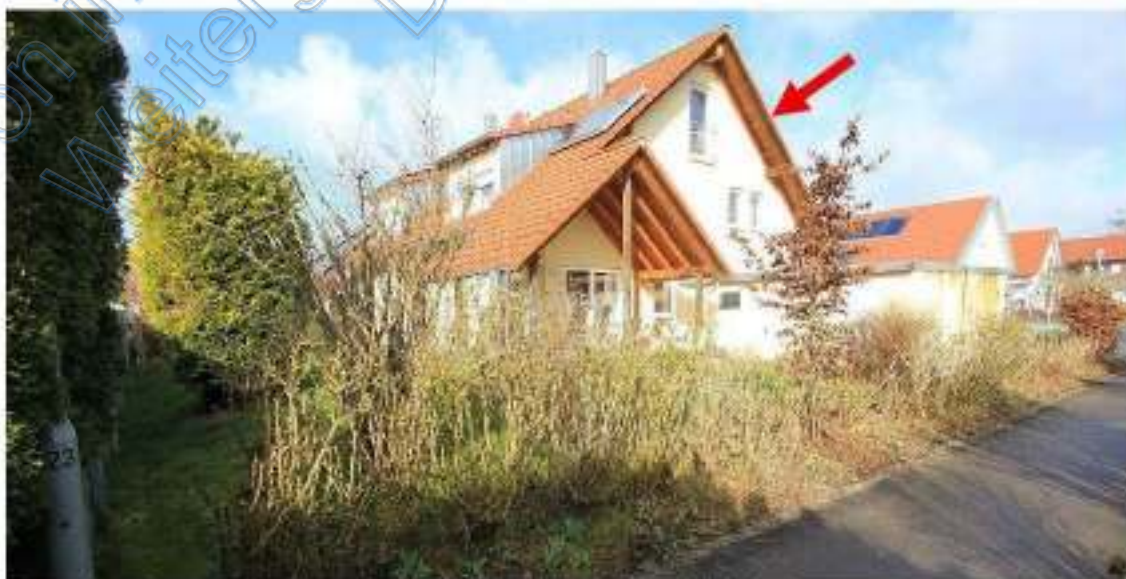
Grundstück von Südosten, Pfeil östliche Haushälfte ATP Nr. 1
