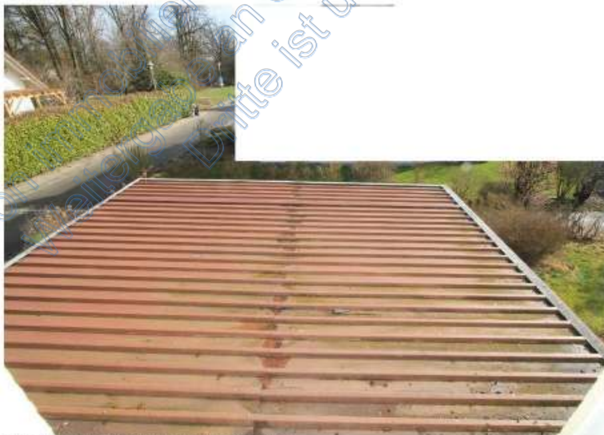
Trapezblechdach der Doppelgarage im Osten
