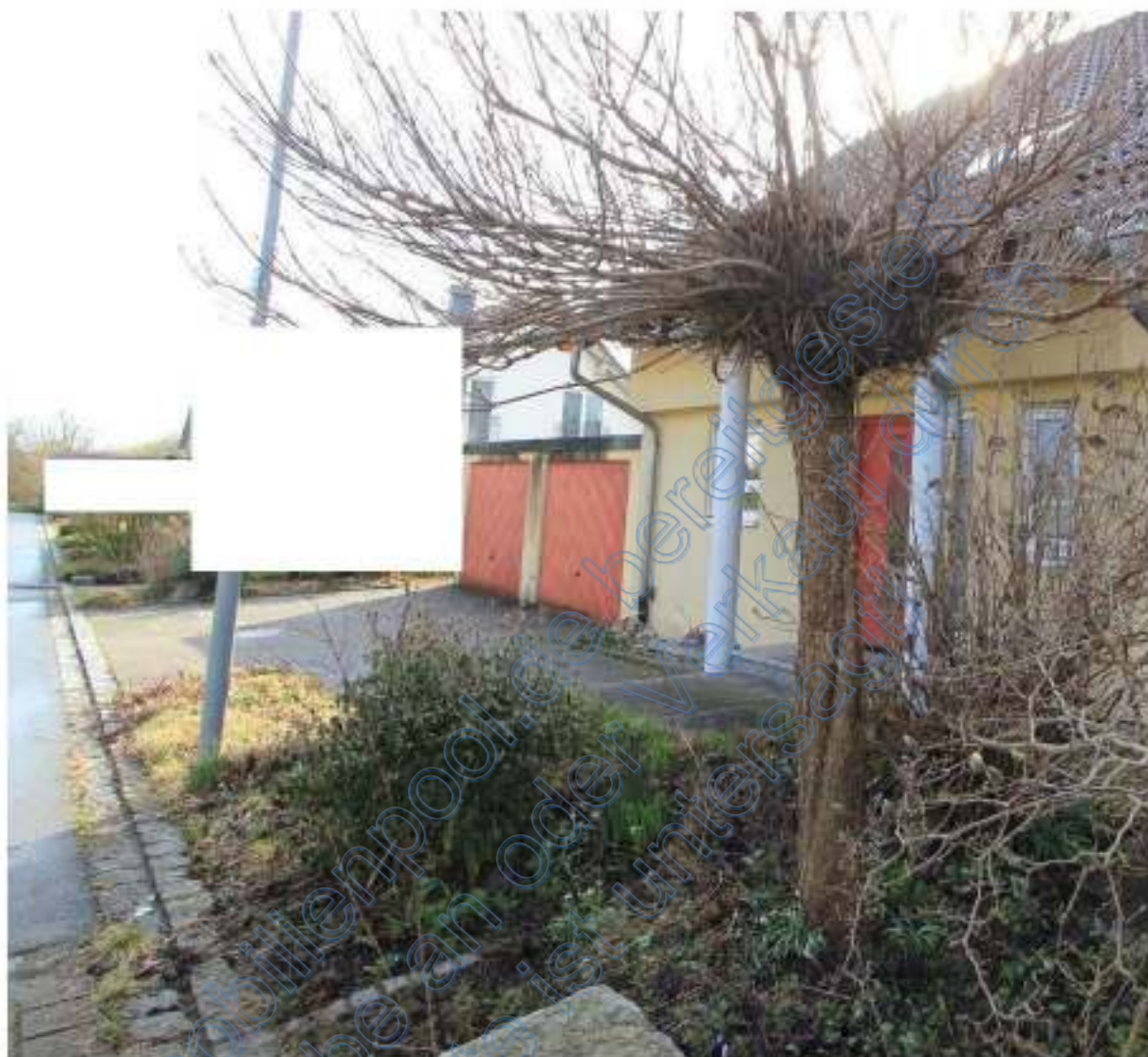
Gesamtes Grundstück mit östlicher Haushälfte ATP Nr. 1 und Doppelgarage von Nordwesten
