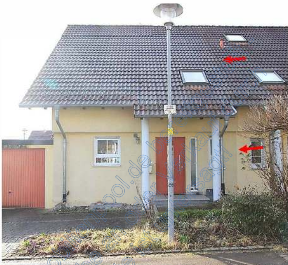
Gesamtes Grundstück mit Doppelhaus von Nordwesten, Pfeile östliche Haushälfte ATP Nr. 1
