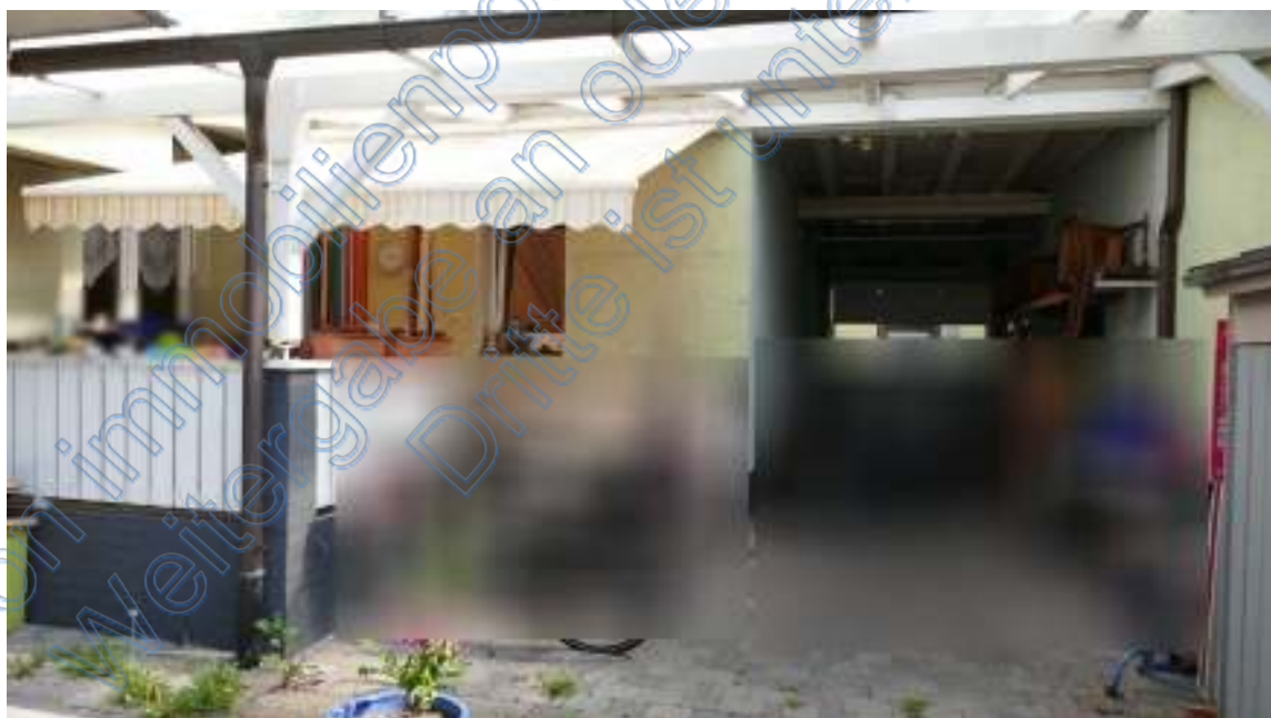
Bild 4: Hofansicht mit Rückseite Gebäude (EG WE Nr. 1)
