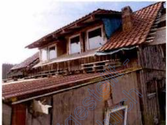
Gebäude D4 – Rohbau Wohnhaus, Südostansicht
