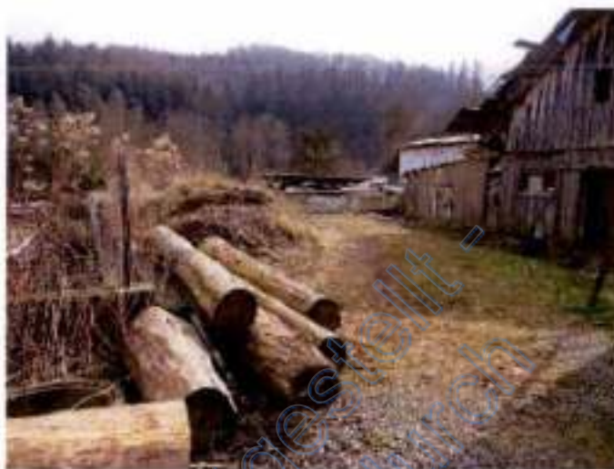
Freiflächen vor Gebäude D4 – Rohbau Wohnhaus
