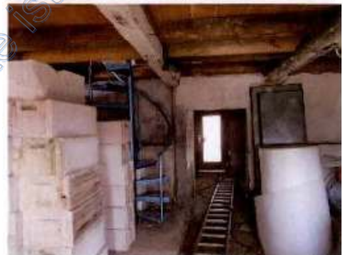
Gebäude D4 – Rohbau Wohnhaus, Innenansicht
