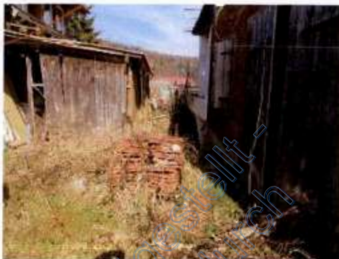
Gebäude D5 (Abbruch) und E3 Abst., Südansicht
