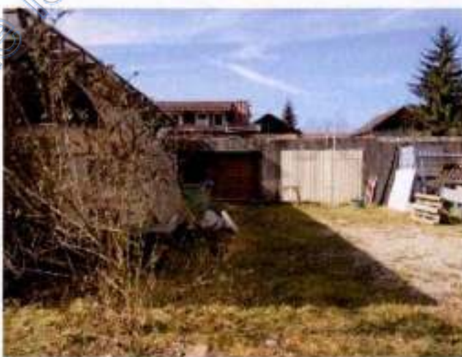
Gebäude E1 – Maschinenhalle und E2 Carport, Ostansicht
