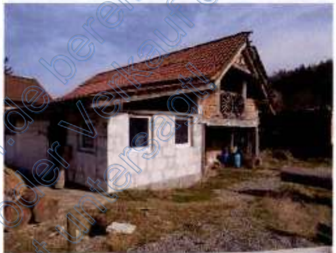
Gebäude D4 – Rohbau Wohnhaus, Südwestansicht
