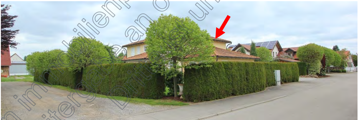
Grundstück von Südosten, Pfeil Wohnhaus
