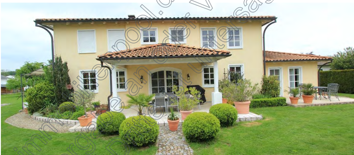
Südseite Wohnhaus mit überdachter Terrasse, rechts Einliegerwohnung im Anbau
