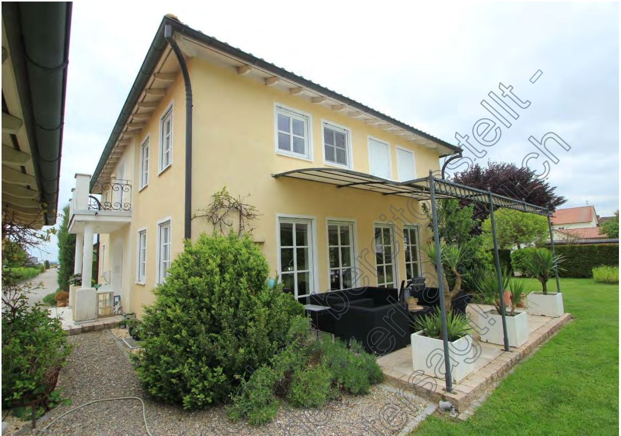
Wohnhaus mit überdachter Terrasse von Westen, links Balkon über Hauszugang
