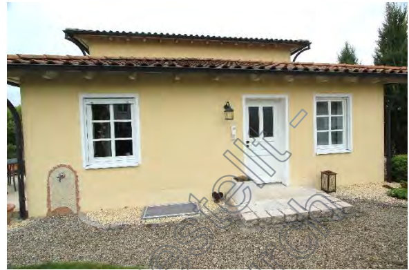
Ostseite mit Einliegerwohnung im Anbau
