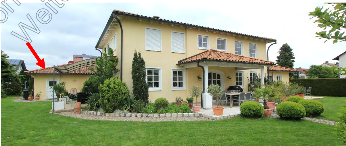
Grundstück mit Wohnhaus von Süden, Pfeil Doppelgarage
