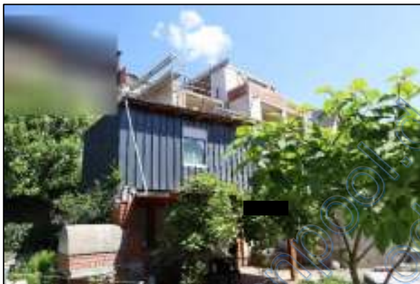
Nebengebäude - Blick nach Nordosten
