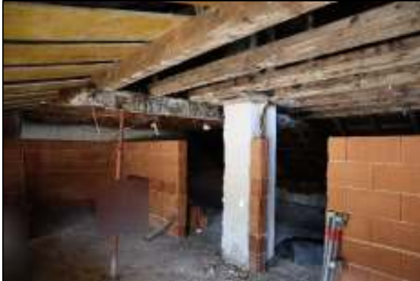
Wohnbereich Dachgeschoss (Aufstockung in Planung)
