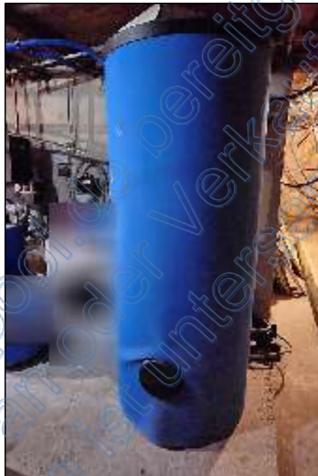
Warmwasserspeicher
