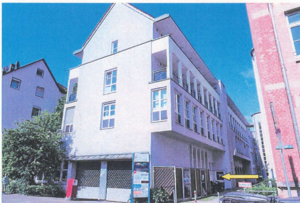
Blick auf das Gebäude Keplerstr. 5 von Nordosten. Der gelbe Pfeil zeigt auf den Hauseingang.
