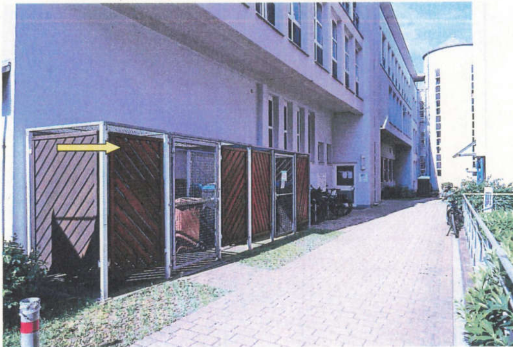
Auf der nördlichen Gebäudeseite befinden sich der Mülltonnenstandort sowie ein Fahrradabstellplatz.
