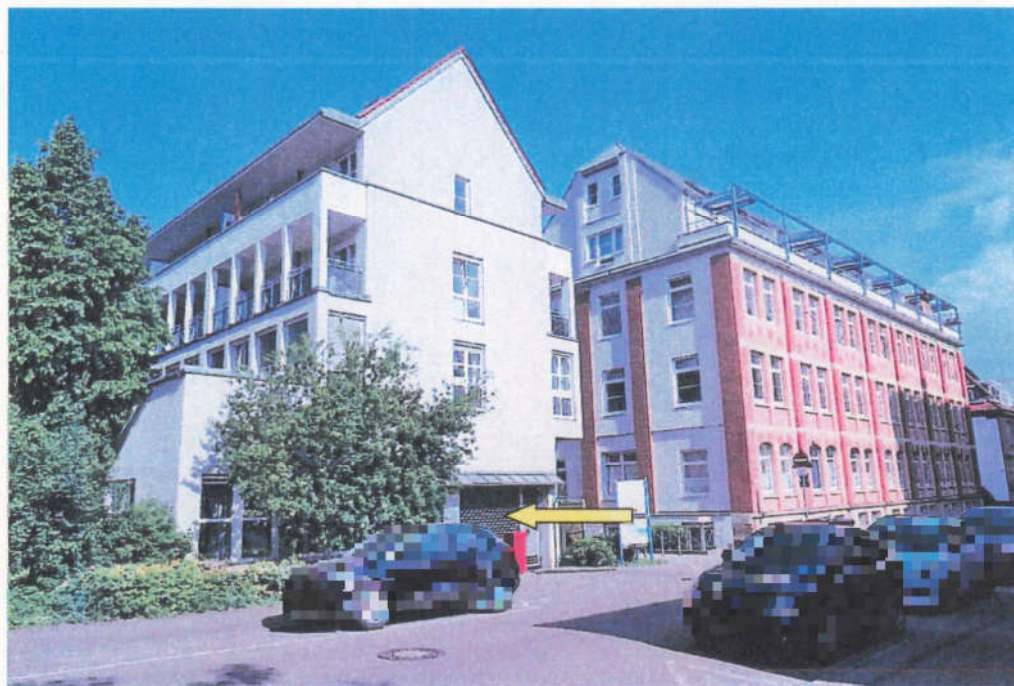
Blick auf die Häuser Keplerstr. 5 und 7 auf dem Flst. Nr. 4276/1 von Südosten aus. Der gelbe Pfeil zeigt auf die Zufahrt zur Tiefgarage.
