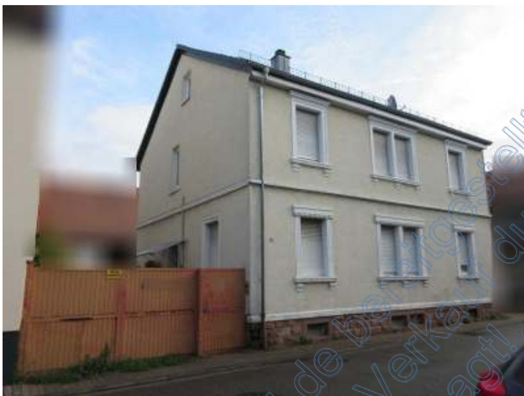
Straßenansicht und Nordwestgiebel
