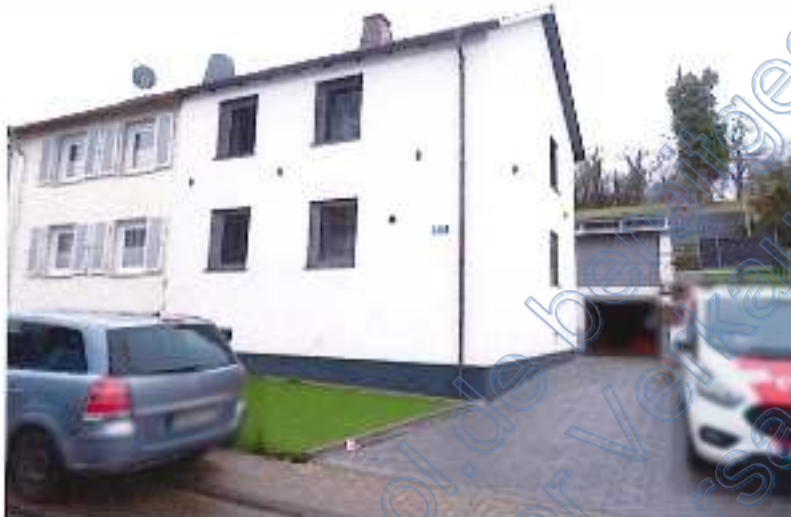
Foto 1: Ansicht von der Straße aus
