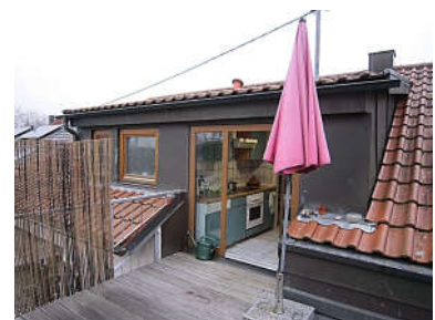
Nördliche Dachgaube mit Ausgang Dachterrasse
