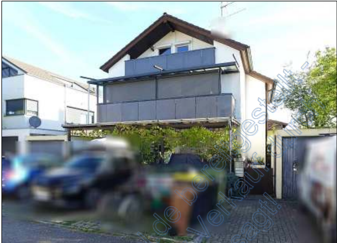
Bild 5 –Zugang und Zufahrt von der Otto-von-Corvin-Straße aus
