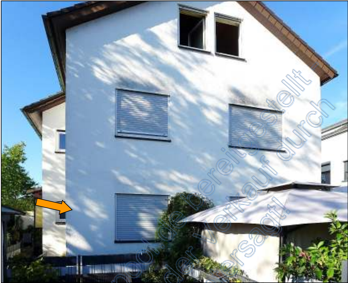
Bild 1 – Blick von Nordosten auf das Gebäude, Gartenseite
