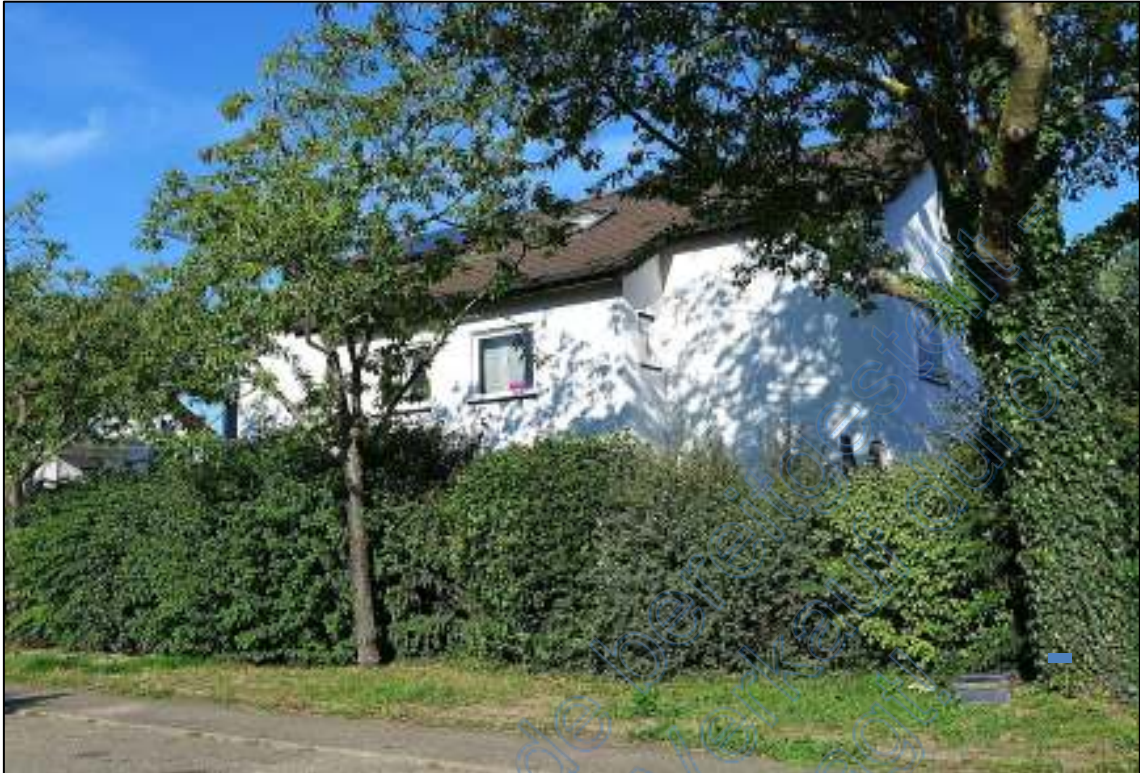
Bild 3 – Blick von Südosten
