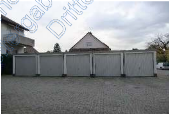
Abb. 21: Blick auf die Pkw-Garagen
