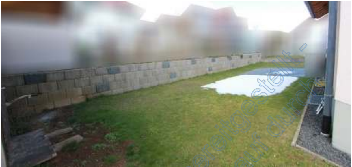
Nördlicher Außenbereich von Westen
