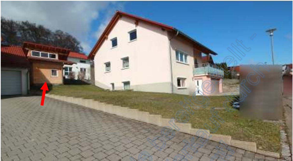
Grundstück mit Wohnhaus von Südwesten, Pfeil massiver Geräteschuppen
