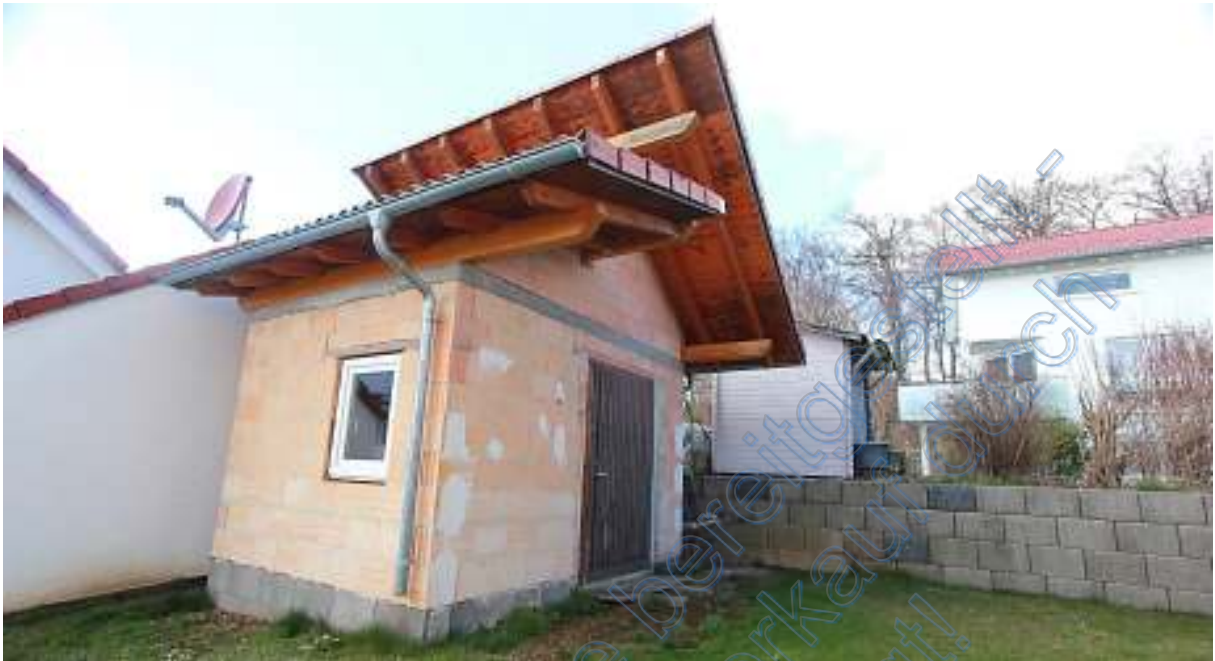
Unverputzter Geräteschuppen im Nordwesten des Grundstücks von Südosten
