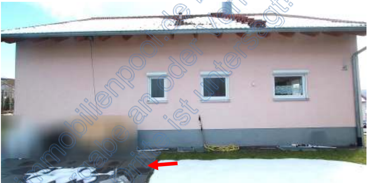
Nordseite Wohnhaus, Pfeil Terrasse
