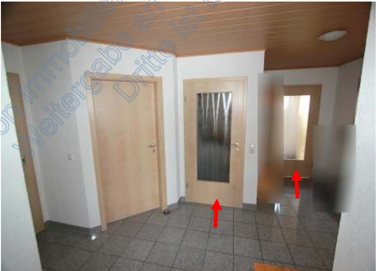
Flur EG, Pfeile Tür zur Kellertreppe und Windfangtür
