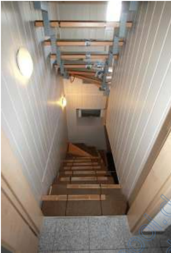
Kellertreppe von oben
