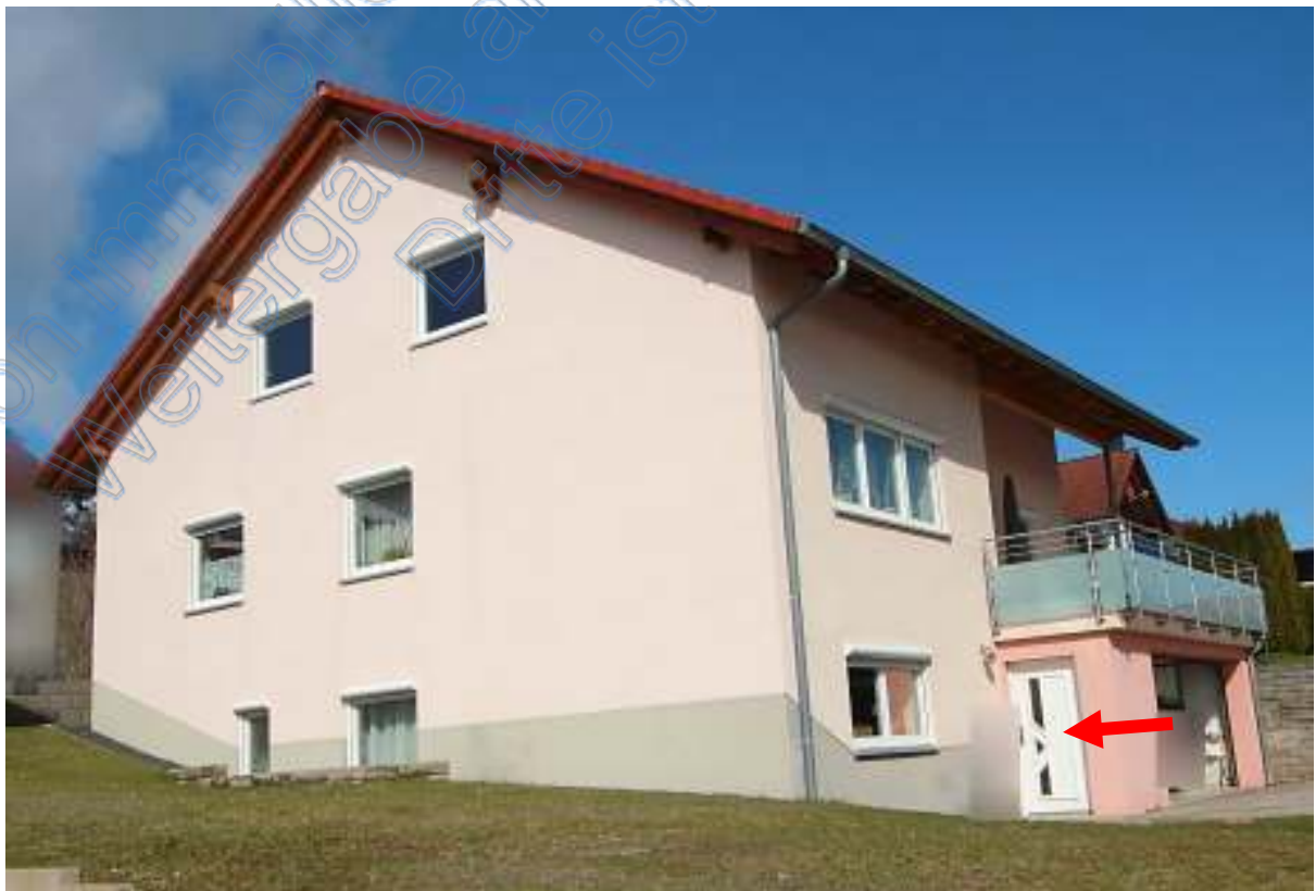
Wohnhaus von Südwesten, Pfeil Tür zur Doppelgarage im UG
