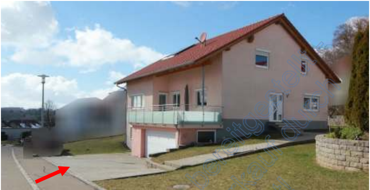
Grundstück mit Wohnhaus von Südosten, Pfeil Vorplatz mit Garagenhof
