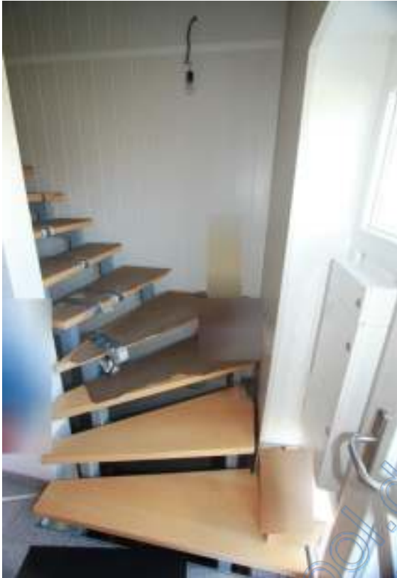
Windfang EG mit Treppe zum DG
