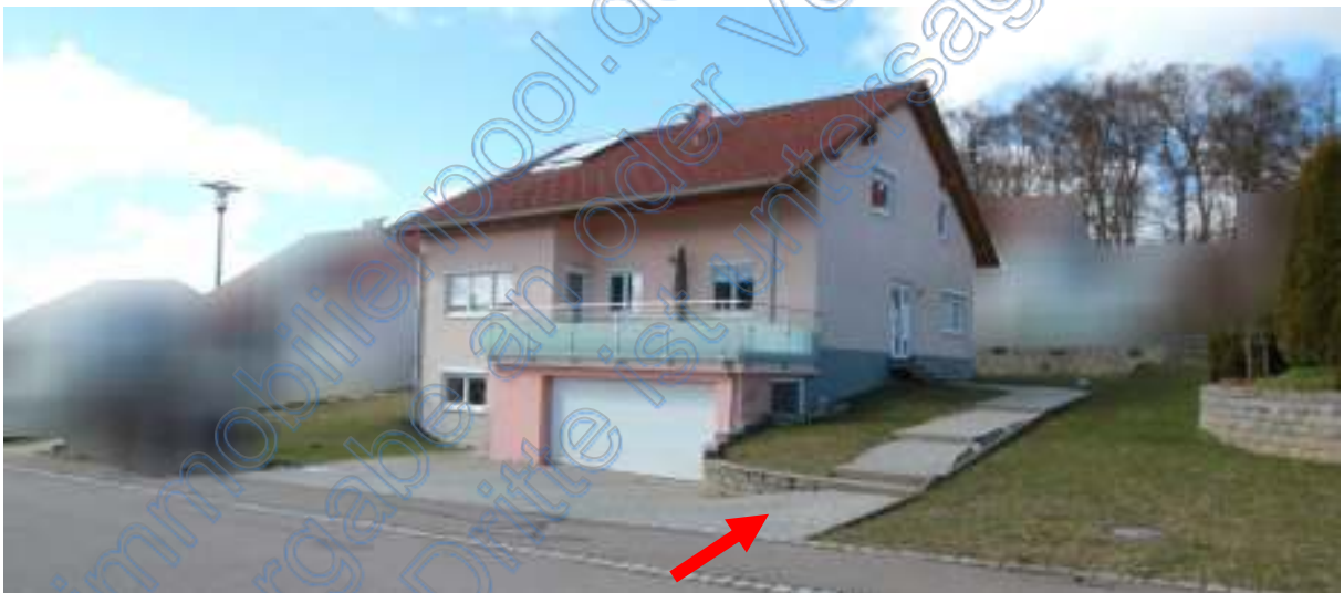
Grundstück mit Wohnhaus von Südosten, Pfeil Hauszugang im Osten
