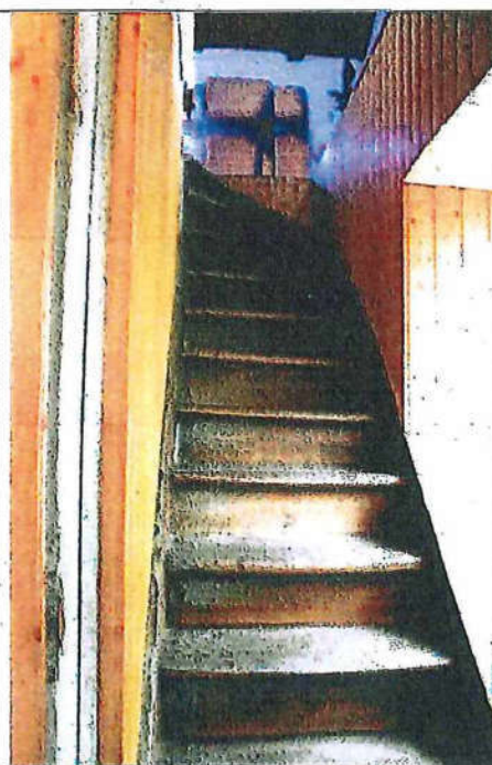
EG Treppenaufgang zum DG
