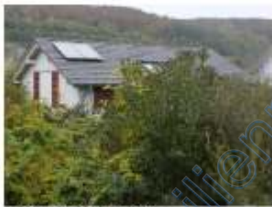
West- und Südseite
