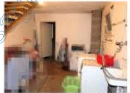
UG Waschküche Richtung Technikraum
