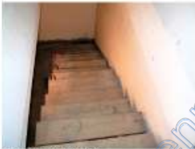
Bautreppe ins UG
