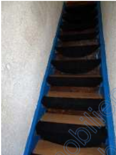
Treppenaufgang im Erdgeschoss
