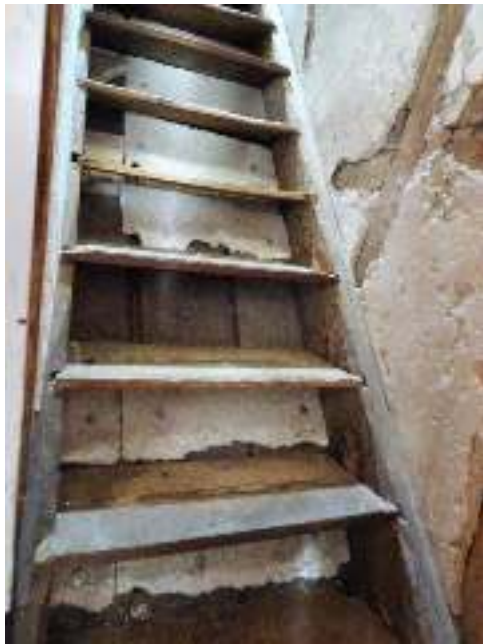
Treppe vom OG ins DG
