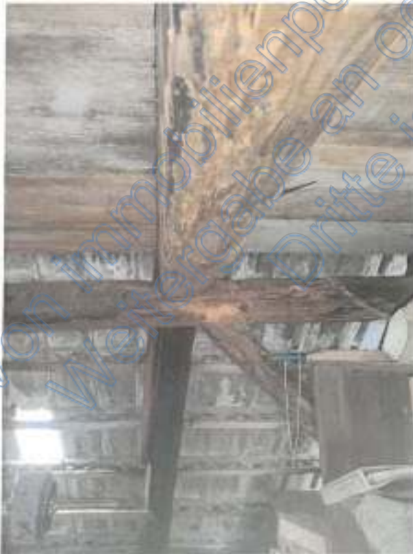
Beschädigte Dachkonstruktion
