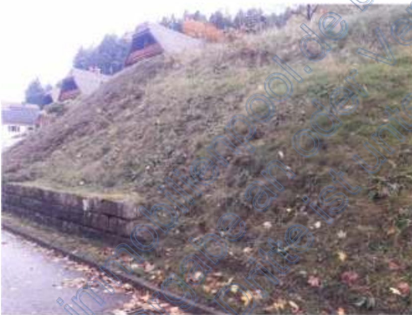
Bild 2: Böschung und Mauer im Nordwesten
