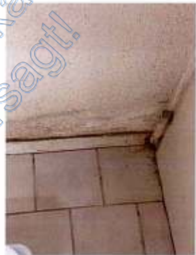
(16) Dito Detail Wand vor Außentür zur Gartentreppe
