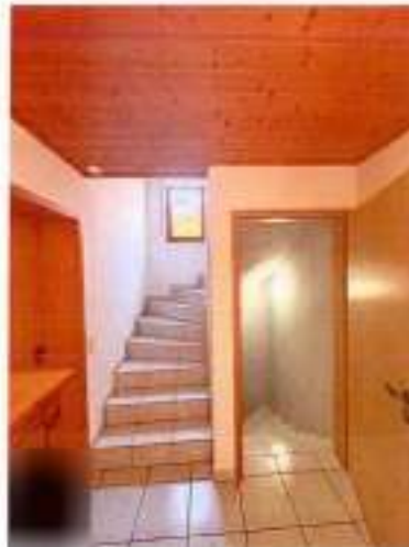
(13) Tür zur Treppe zum UG
