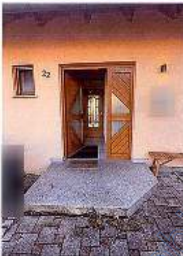
(67) Granitplatte an der vorderkante der Stufe fehlt
