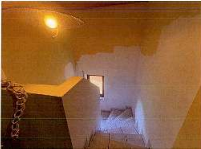
(51) Treppenhaus im DG
