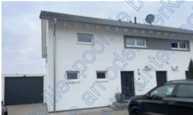
Ansicht Gebäude mit Garage
