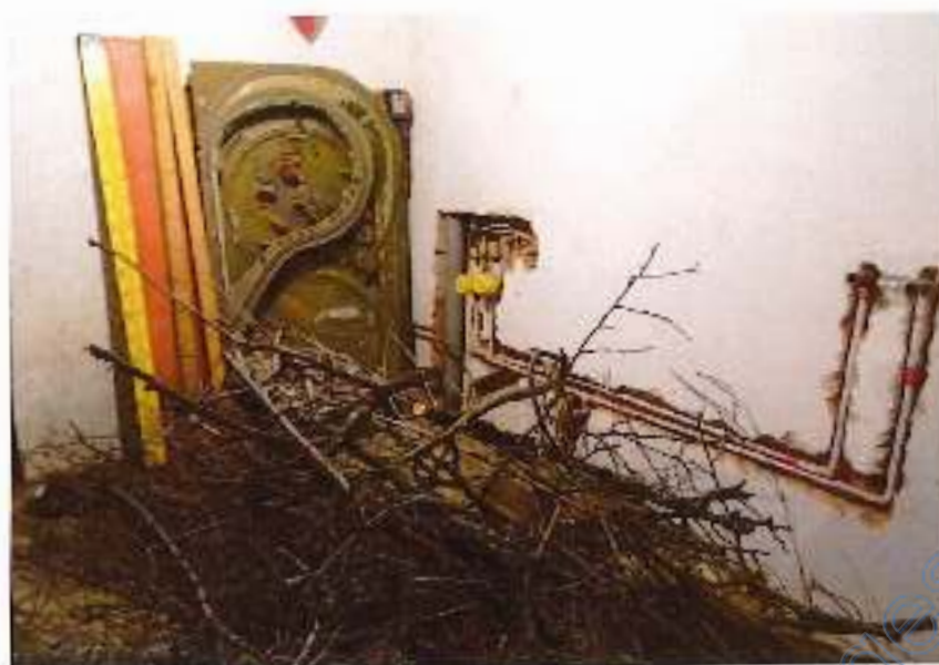
Foto 20: Unfertige Leitungs- Installationen im EG
