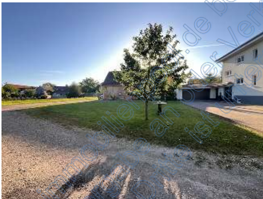
Lange Straße 45 aus Richtung Westen
