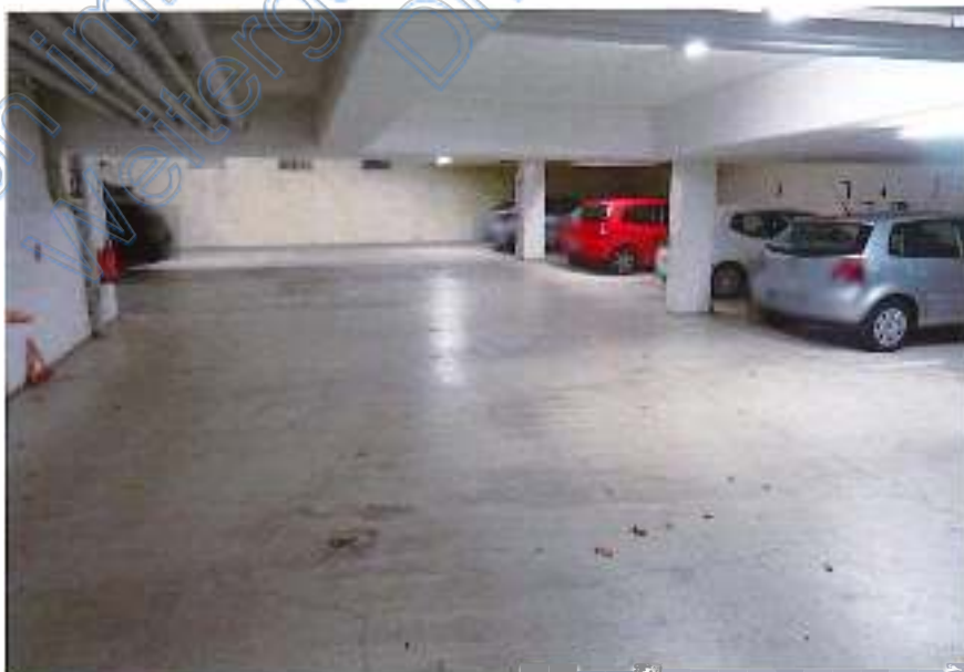
Foto 5: Blick in die Tiefgarage
