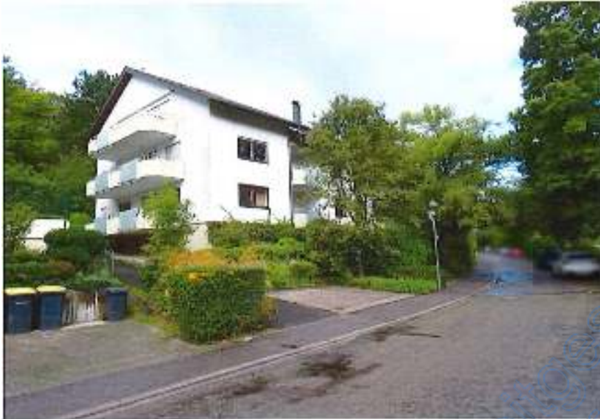
Foto 3: Ansicht des Mehrfamilienhauses von der Straße aus (Süd- und Westseite)
