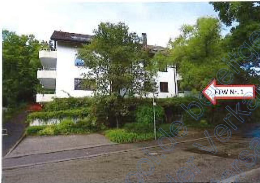
Foto 1: Ansicht des Mehrfamilienhauses von der Straße aus (Südseite)
