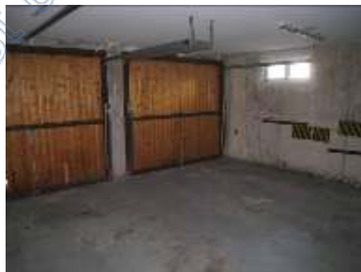
Innenansicht Garagen im Untergeschoss
