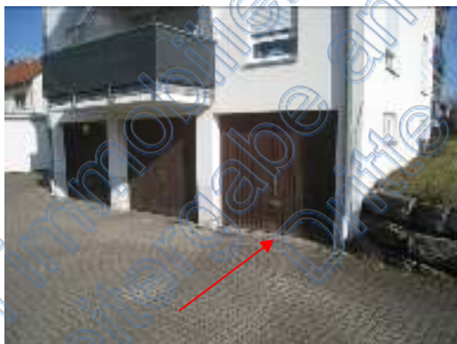
Außenansicht Garage Nr. 9
