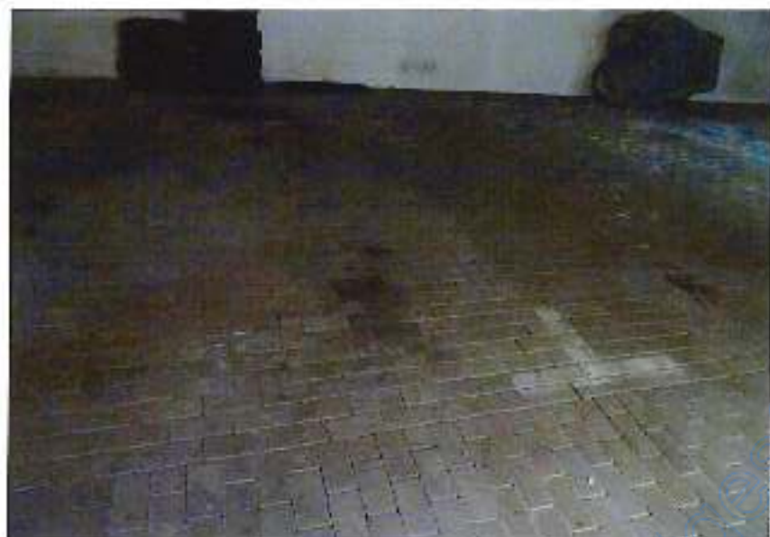
Foto 12: Ölflcken auf Tiefgaragenboden
