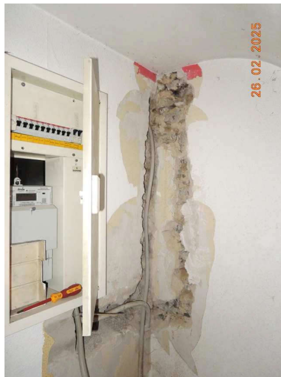
Abb. 14: Sicherungskasten, begonnene Modernisierung der Elektrik
