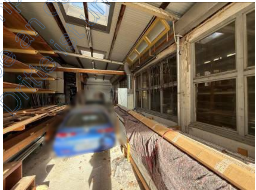
Foto 6 des SV: Ansicht von Südosten; Außenlager überdacht
