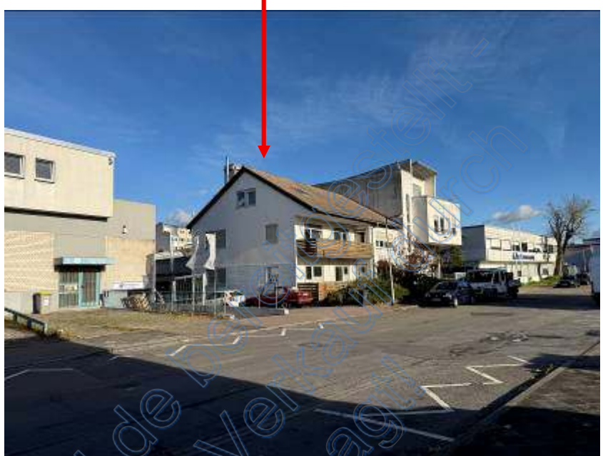
Foto 1 des SV: Anwesen Franz-Grashof-Straße 11; Ansicht von Südwesten, Straßenansicht, Markierung durch den SV
