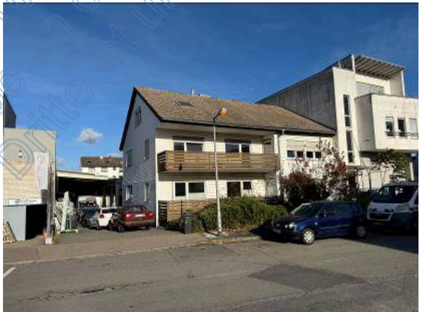
Foto 2 des SV: Ansicht von Südosten, Wohngebäude
