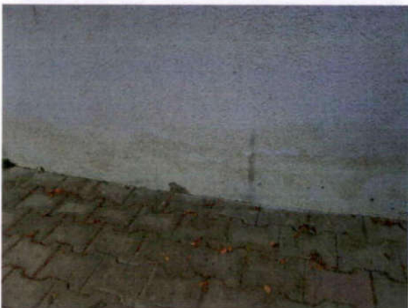
Aufsteigende Feuchtigkeit Außenwand zwischen Garage und Hauseingang
