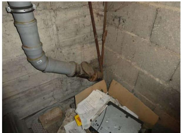
Kelleraußenwand in Beton, Innenwand HBL-Mauerwerk
