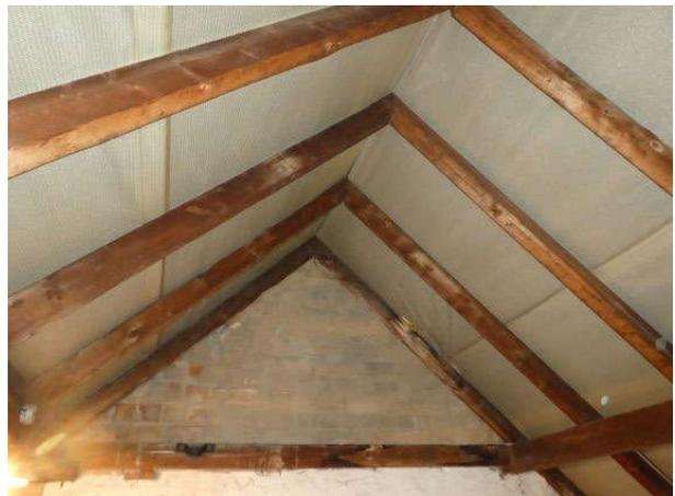
Giebel, Ziegelsteinmauerwerk erkennbar, ohne Firstbalken
