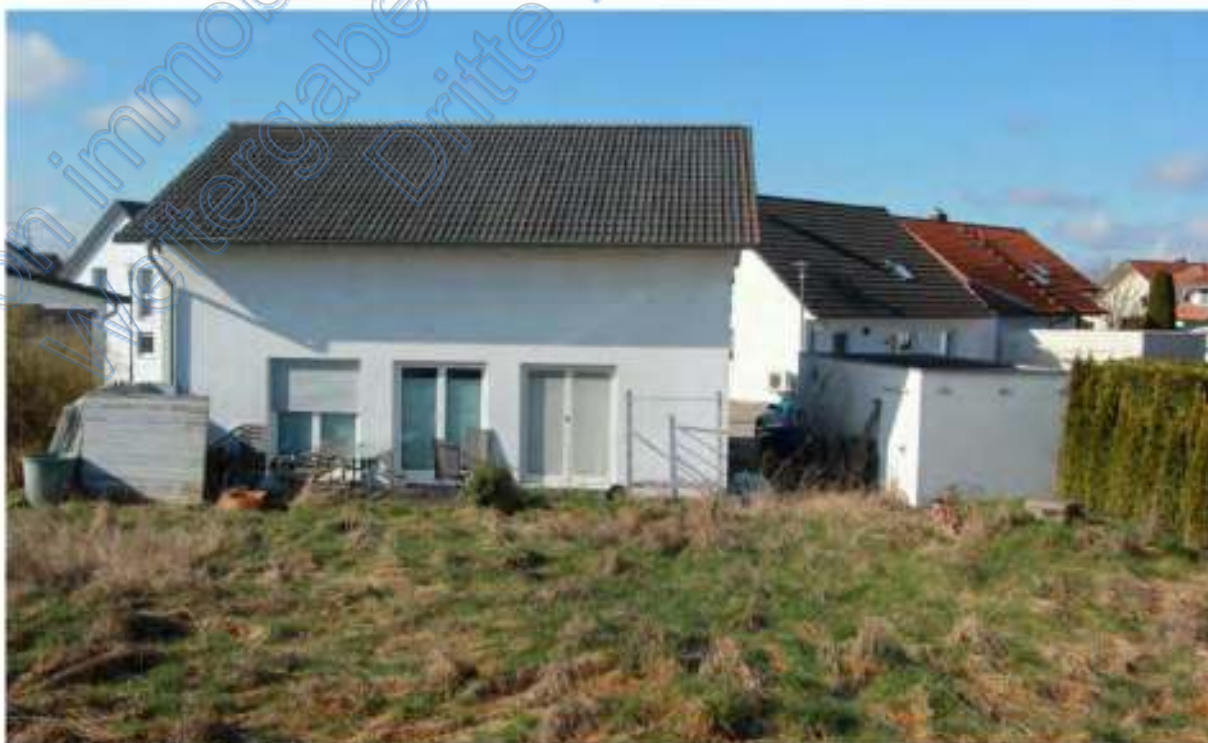
Nordostseite Wohnhaus und Fertiggarage
