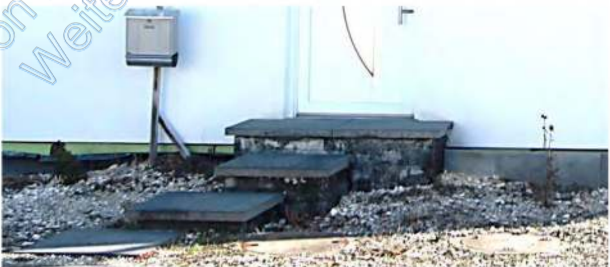
Provisorische Eingangstreppe und Briefkastenhalterung
