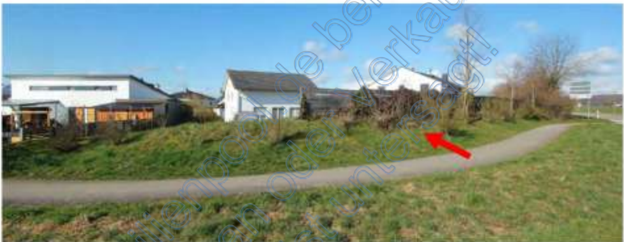
Blick von Nordosten zum Grundstück, Pfeil Schallschutzhügel, davor Fußweg
