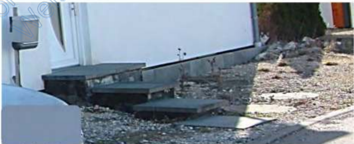
Provisorische Eingangstreppe und unangelegter Vorplatz
