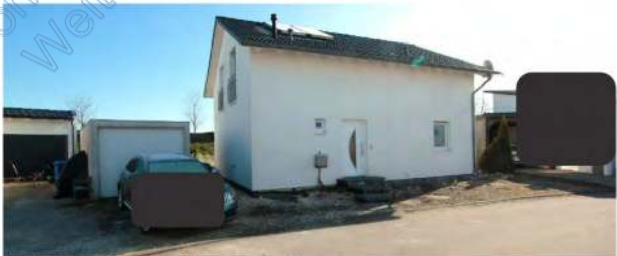
Grundstück mit Garage und Wohnhaus von Westen
