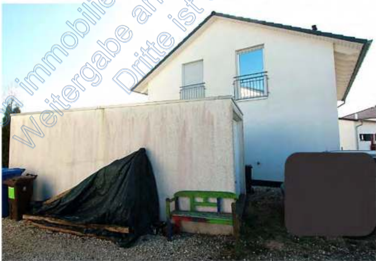
Nordwestseite Fertiggarage und Wohnhaus
