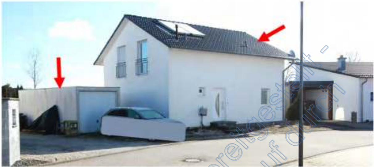
Grundstück mit Fertiggarage und Wohnhaus von Westen
