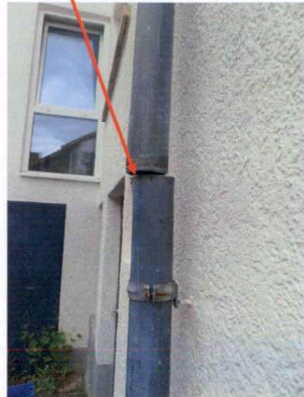
defektes Abwasserrohr
