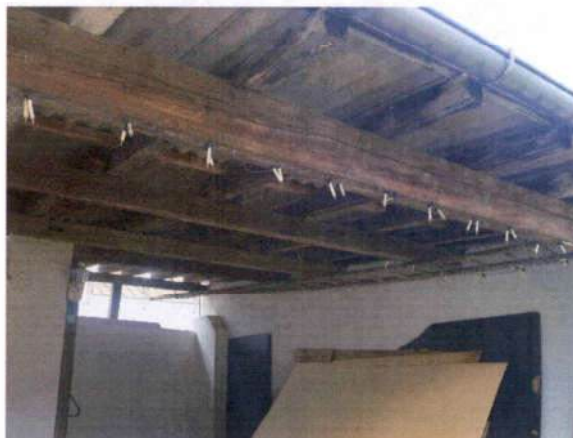
Feuchtigkeitsschäden im Holzgebälk der Überdachung
