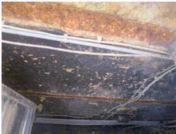
Rost an den Stahlträgern in der Decke
