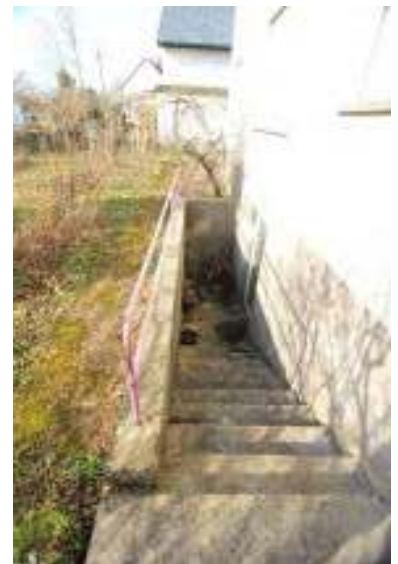
Kelleraußentreppe im Süden
