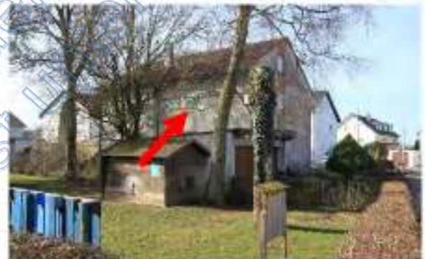
Blick von Nordosten, Pfeil Wohnhaus
