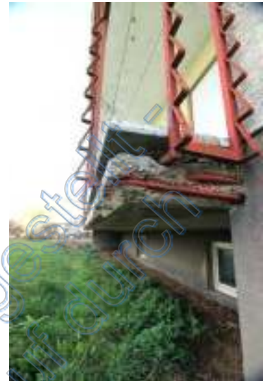
Betonabplatzungen EG
