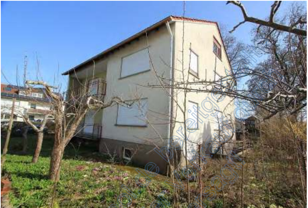
Wohnhaus von Südwesten
