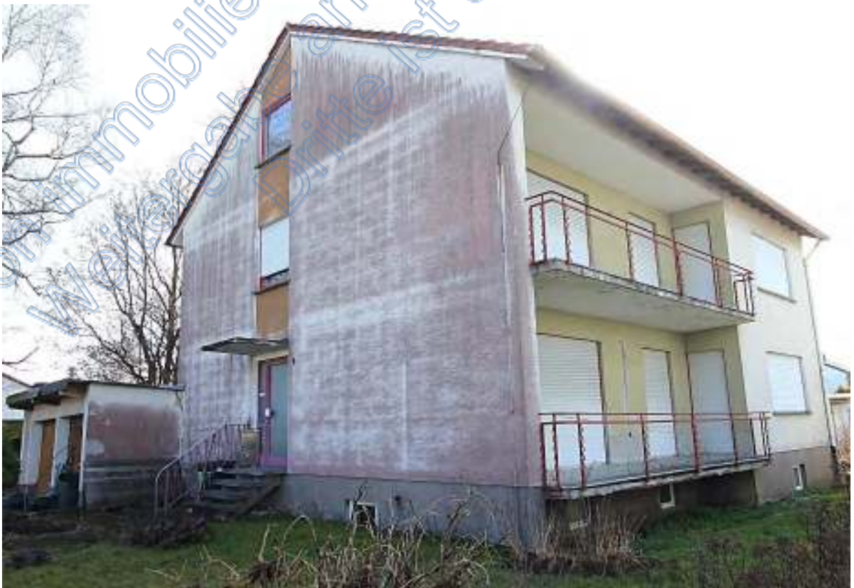
Wohnhaus mit Doppelgarage von Nordwesten
