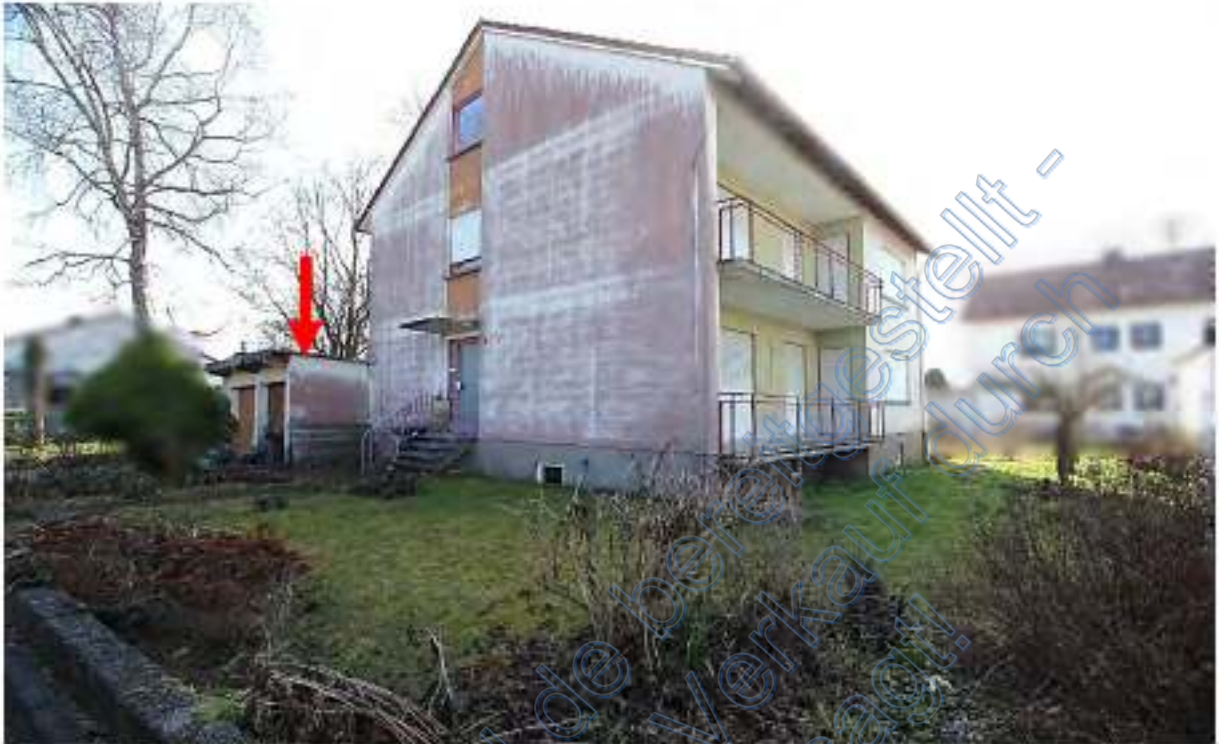
Grundstück mit Wohnhaus von Nordwesten, Pfeil Doppelgarage
