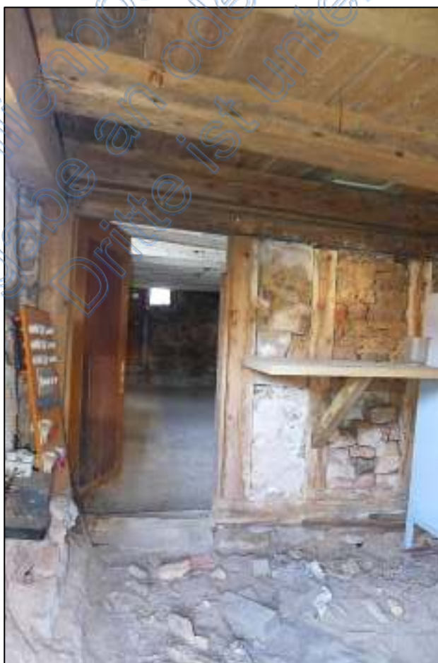
Bild 12 – Blick in den Ökonomiebereich (Lager 4)
