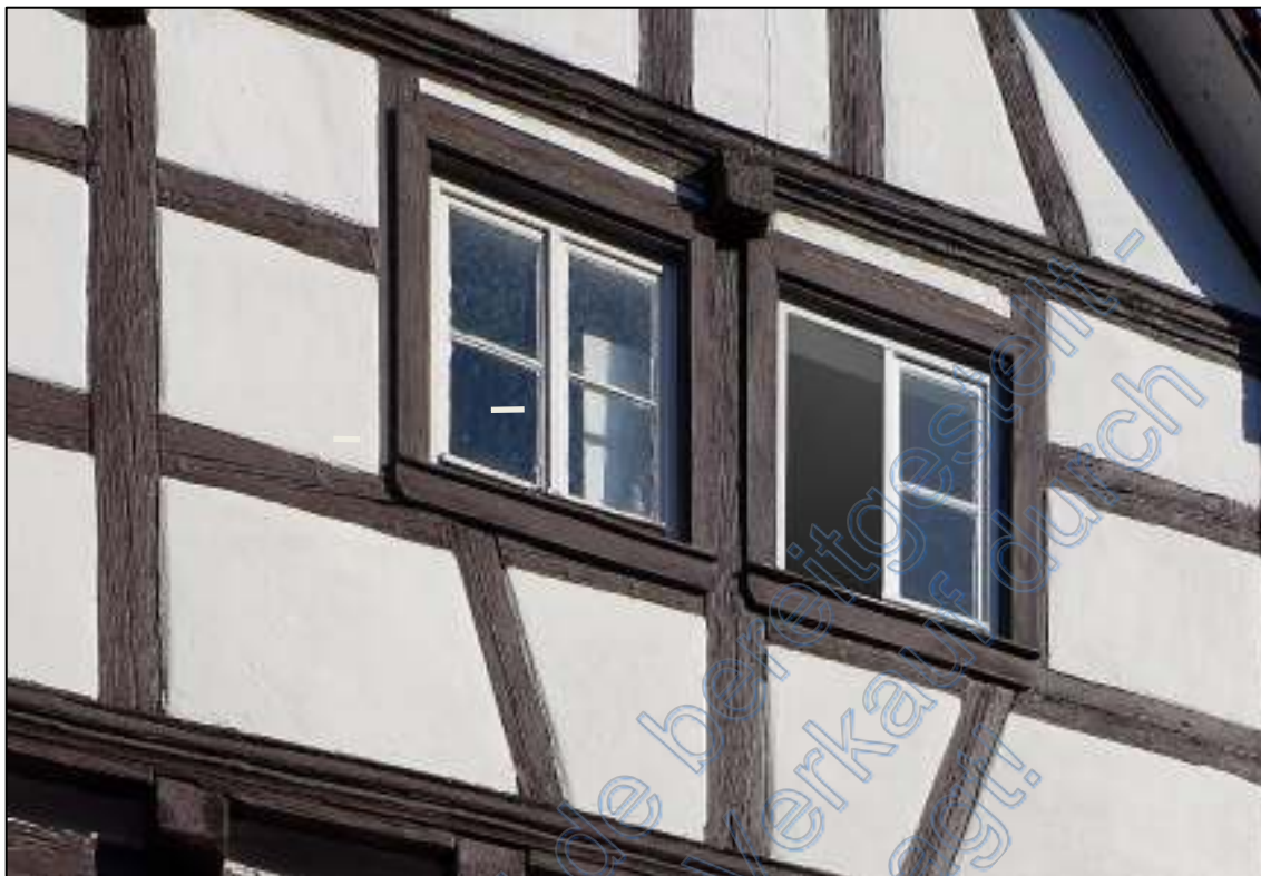
Bild 11 – Straßenseite, offenes Fenster im unbewohnten Haus
