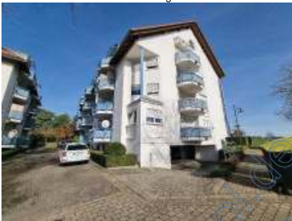
Zugang TG Fichtenweg 2
