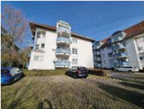
Blick auf die Liegenschaft
