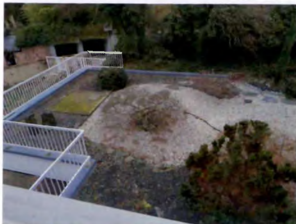
Vorgarten, Dach der Tiefgarage
