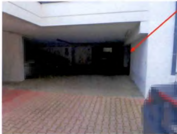
Tiefgarage, Zugang zum Haus markiert
