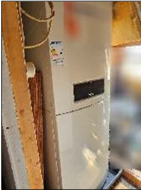
Heizungsanlage (Gas-Brennwert)
