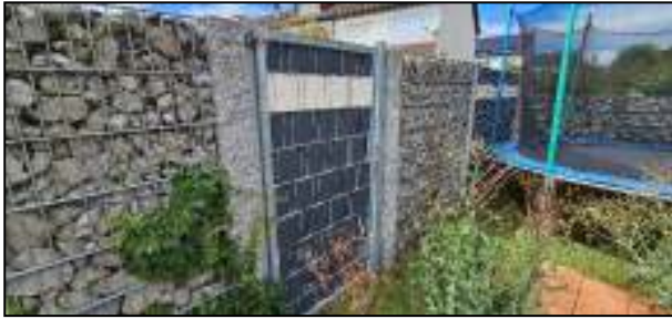
Zaunanlage mit Tor gegen südwestl. Gehweg
