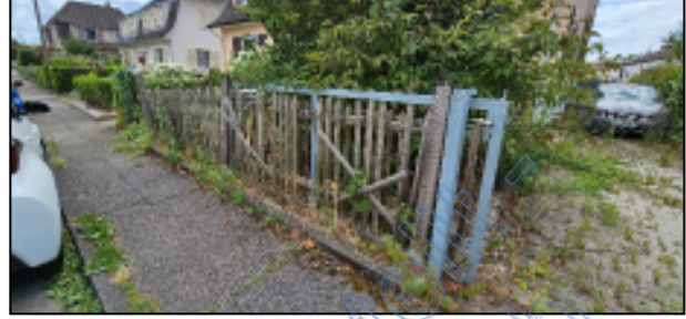
Zaunanlage gegen Hermann-Währer-Straße
