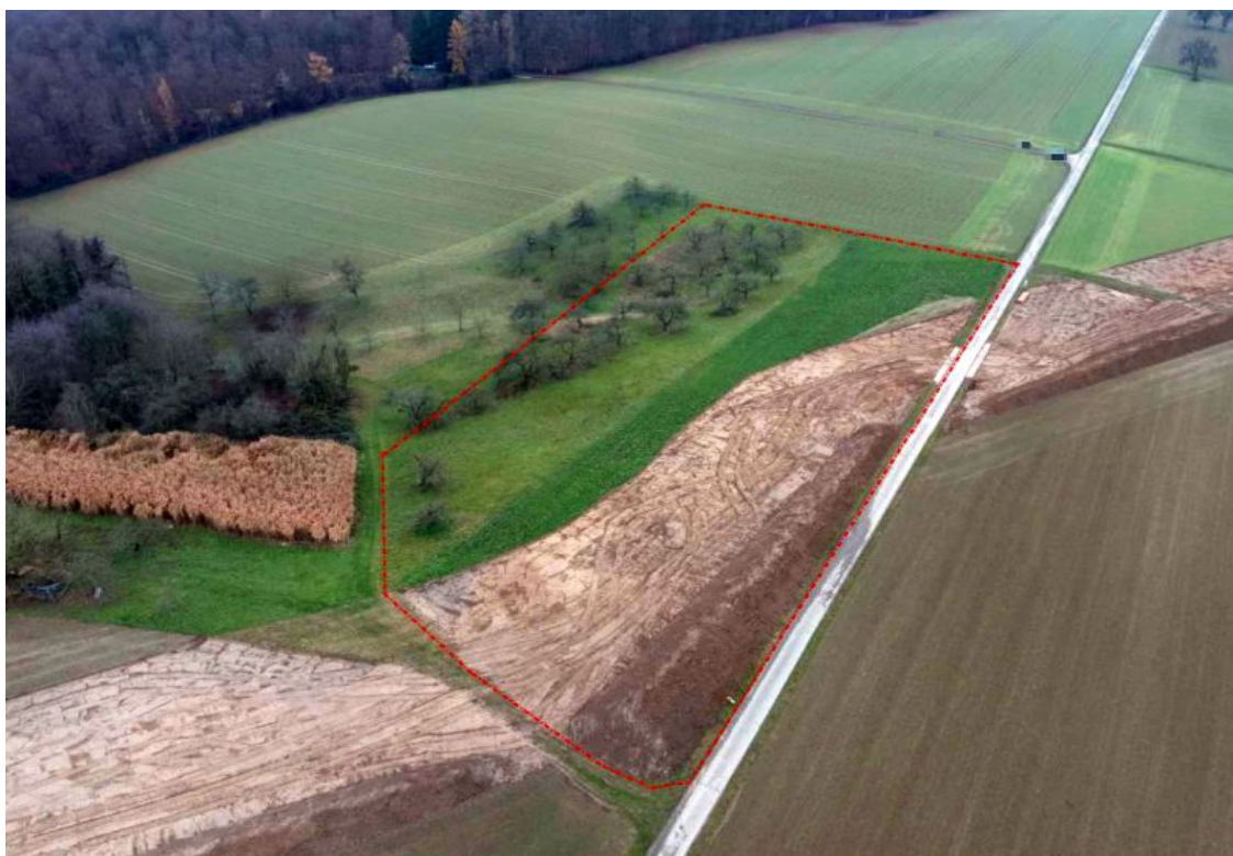
Bild 1: Gesamtansicht der zu bewertenden Fläche, Sicht von Süden; Grenzen in rot markiert
