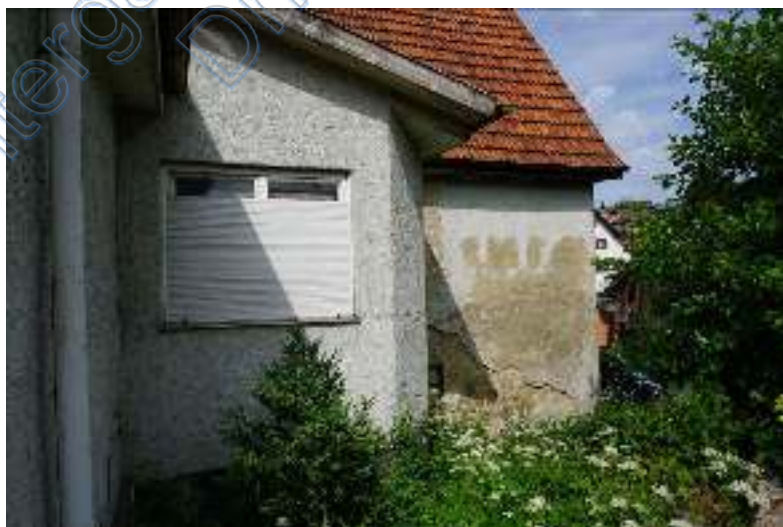
Foto 3: Ansicht West, Bad-Anbau (EG), Stall / Scheuer
