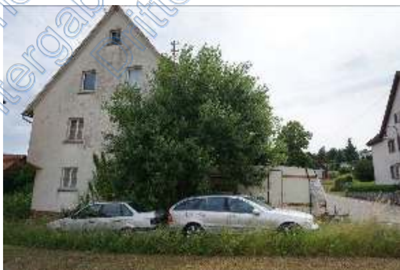
Foto 6: Ansicht West, Wohnhaus
