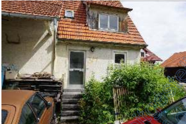
Foto 16: Wohnhausanbau östlich, straßenseitige Ansicht
