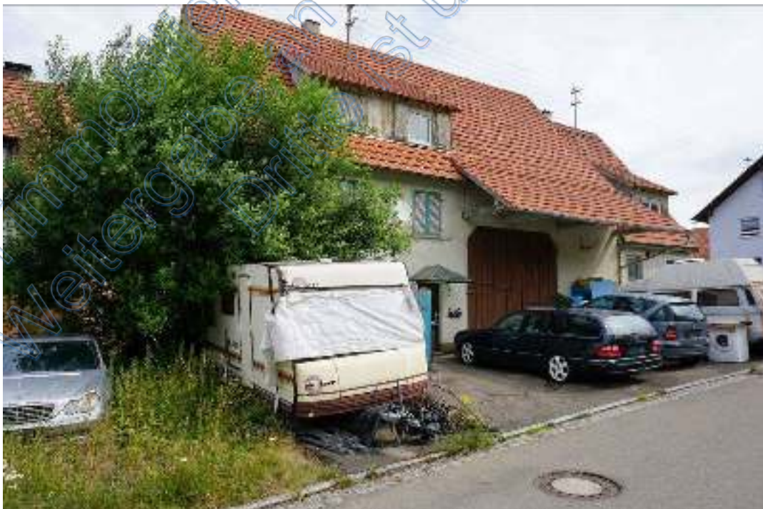
Grabenstraße 3, Flst 393, Ansicht Nord-West
