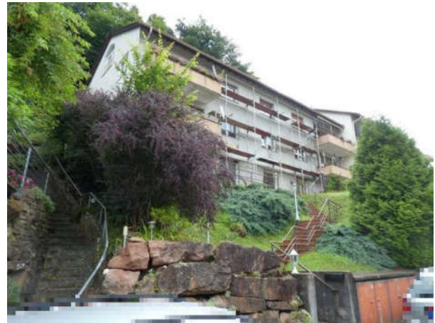
Südwestansicht Gebäude Nr. 19
