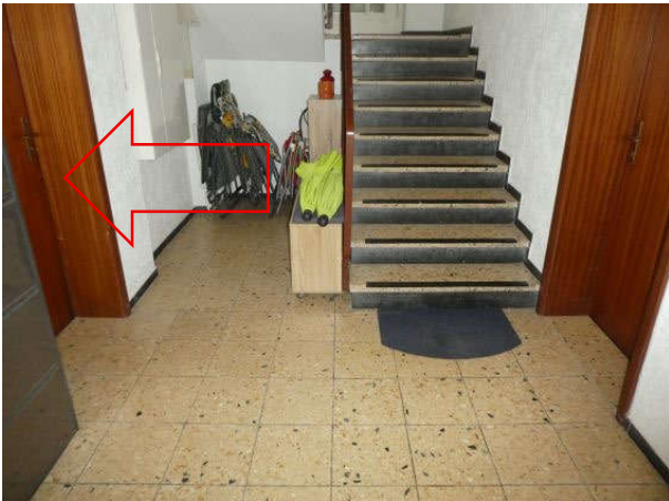
Treppenhaus im EG des Hauses Nr. 21
