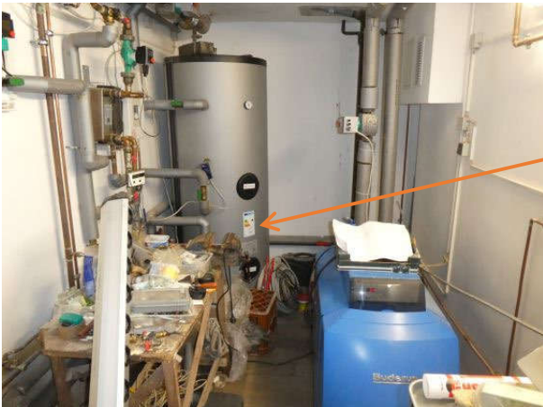
Heizungsraum, Öl-Zentral-Heizung
