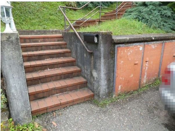
Treppenaufgang, Ort beton, Fliesenbelag, Eisenhandlauf
