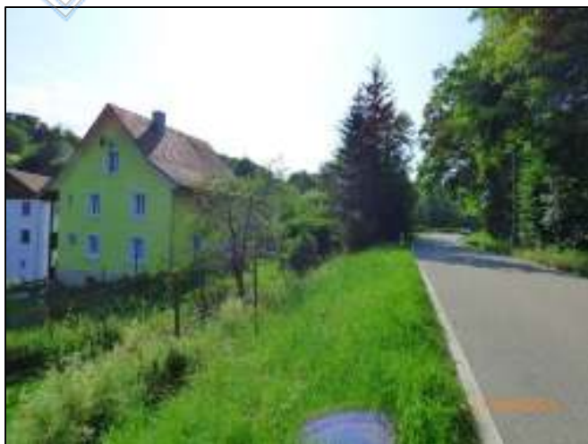
Ansicht: Ostseite, Kreisstraße (Bild 6)
