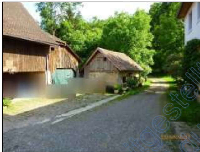
Ansicht: ehem. Stallung (Bild 13)
