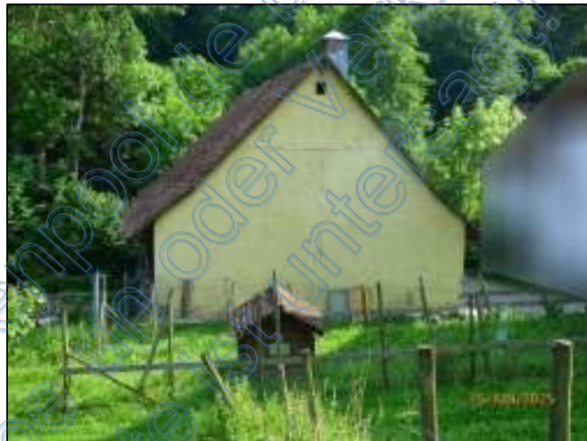
Ansicht: Nordseite Scheune (Bild 11)
