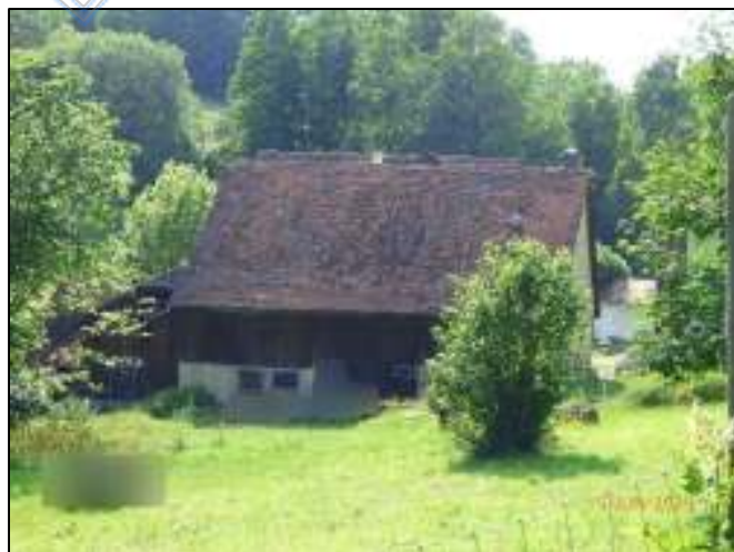
Ansicht: Ostseite Scheune (Bild 12)
