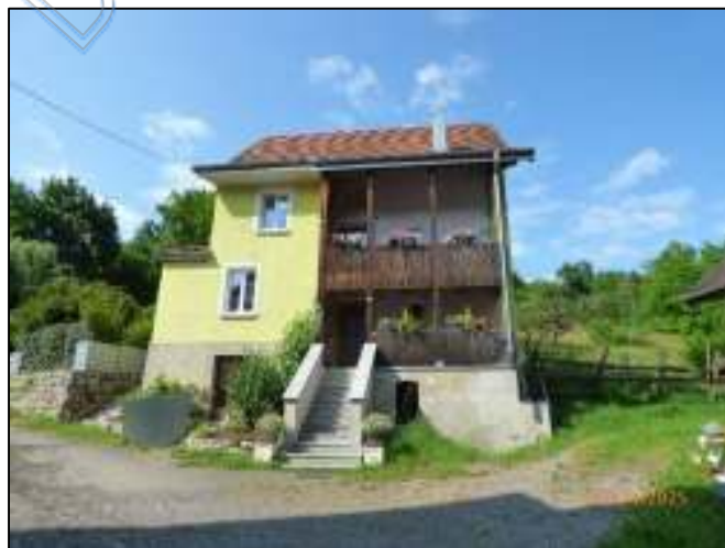
Ansicht: Südseite, Balkon (Bild 3)
