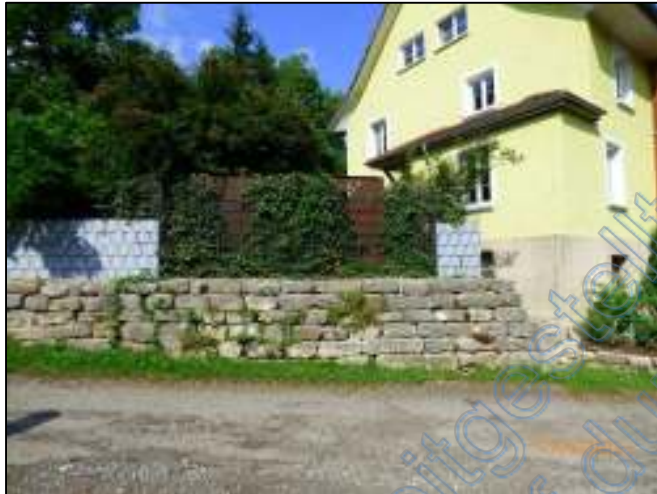
Ansicht: Südwestansicht, Hauseingang, Sichtschutz (Bild 4)
