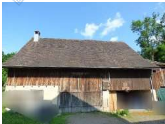
Ansicht: Scheune, Lager (Bild 9)
