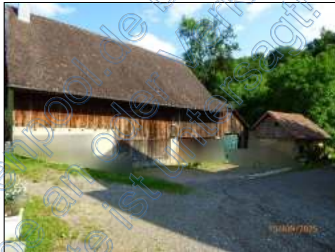
Ansicht: Scheune mit ehem. Stallung (Bild 8)
