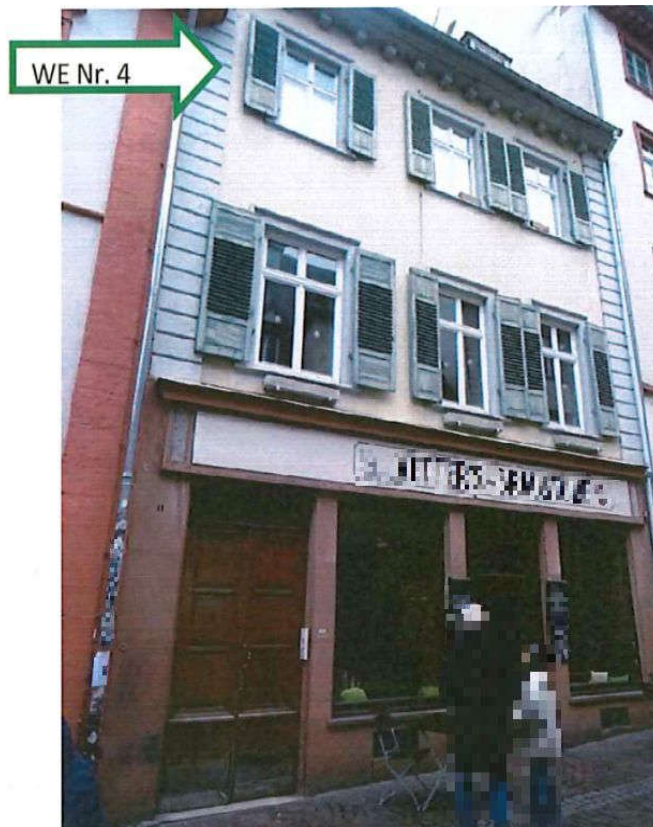
Foto 3: Ansicht von der Straße aus
