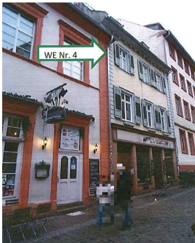
Foto 1: Ansicht von der Straße aus
