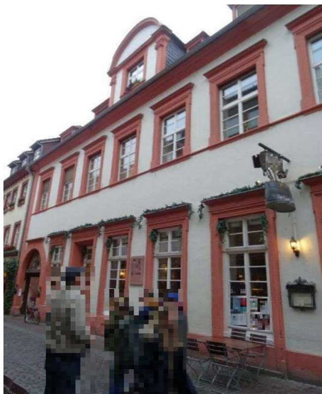
Foto 2: Ansicht des Nachbar- hauses von der Straße aus
