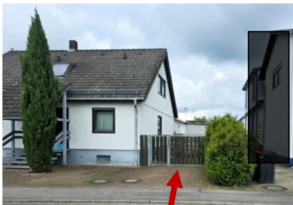
Einfahrt zur Lagerhalle
