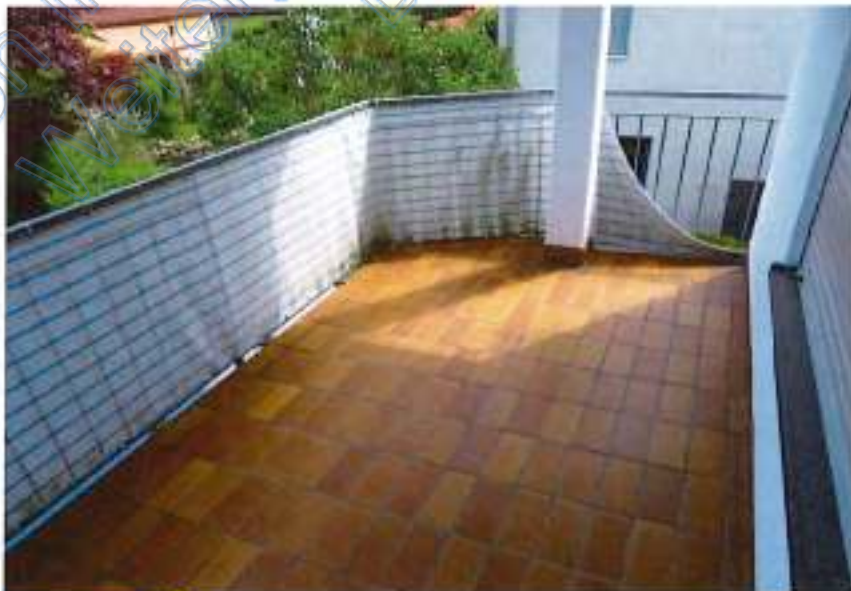
Foto 22: Balkon im OG, Gartenseite
