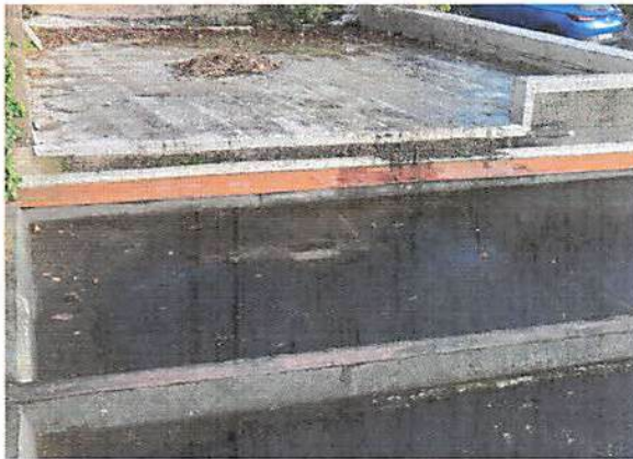
Feuchtigkeit Garagendach, Zulauf von der Nachbargarage
