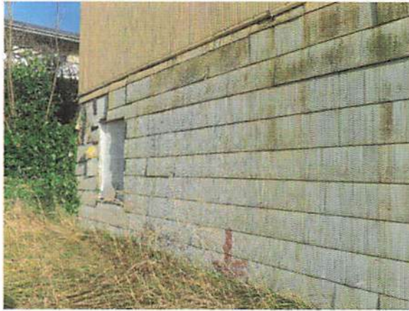
schadhafte Fassadenverkleidung an der Westseite
