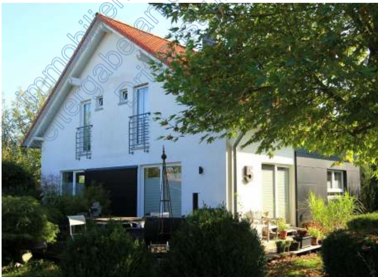
Wohnhaus von Südwesten
