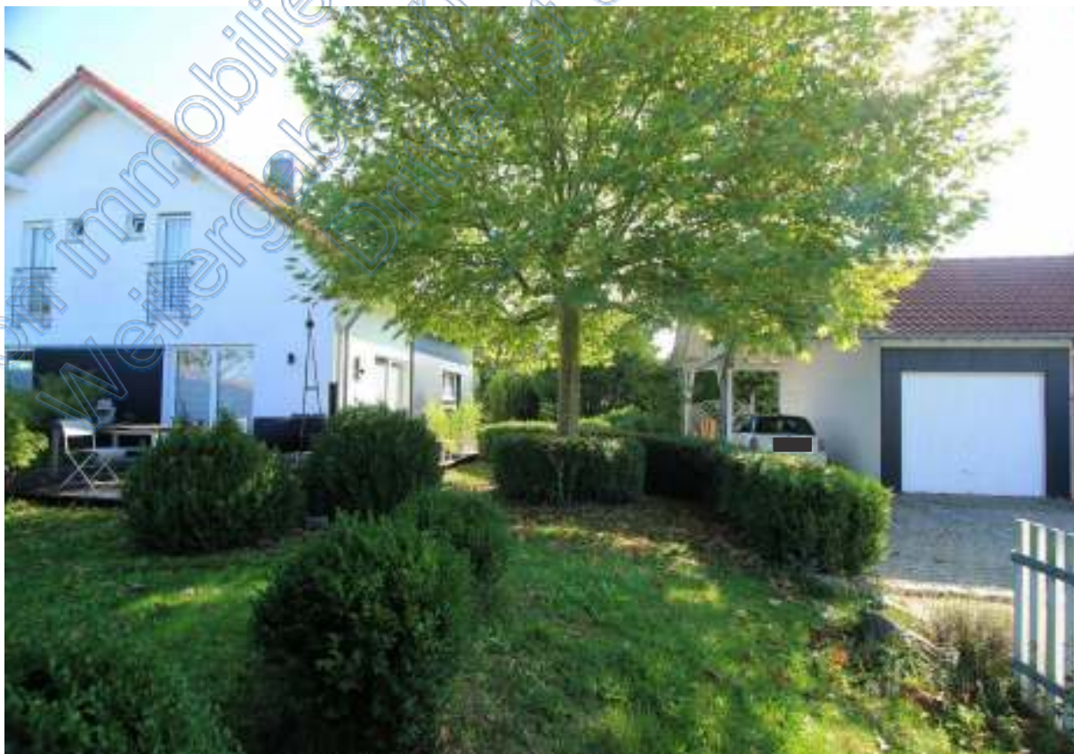
Grundstück von Westen, links Wohnhaus, rechts Carport/Garagegebäude
