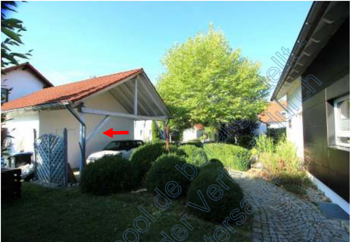
Carport/Garagegebäude (links), Hauszugang und Wohnhaus von Osten
