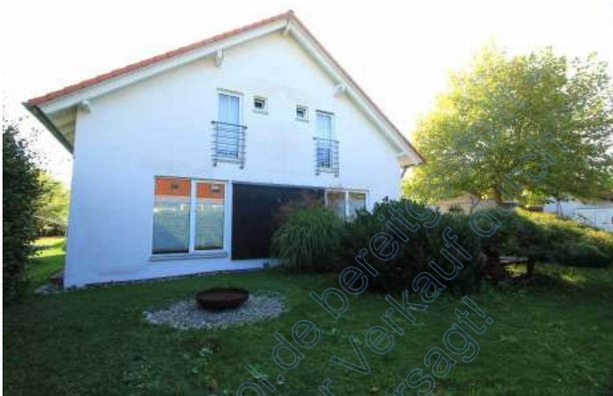
Westseite Wohnhaus mit anthraziter Plattenverkleidung im EG, vorne Garten
