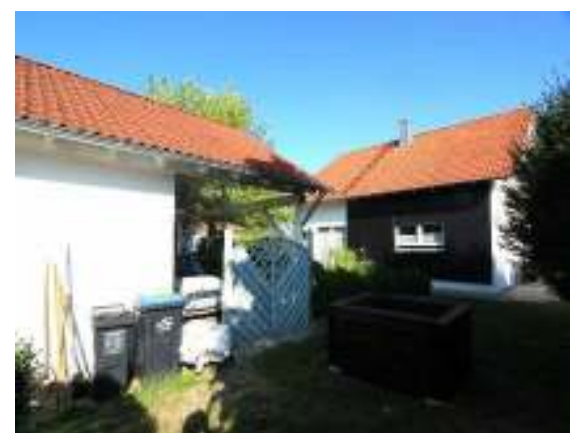
Carport/Garagegebäude, hinten Wohnhaus
