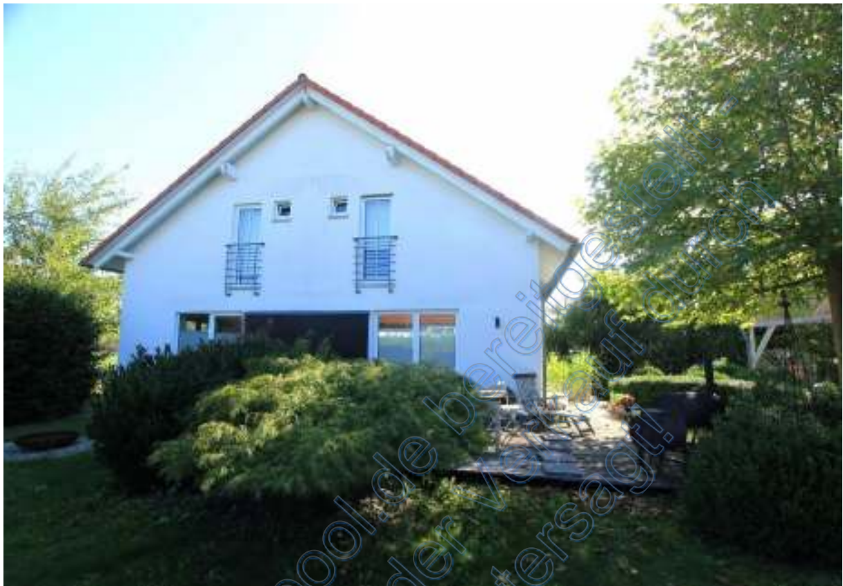
Westseite Wohnhaus mit Holzterrasse
