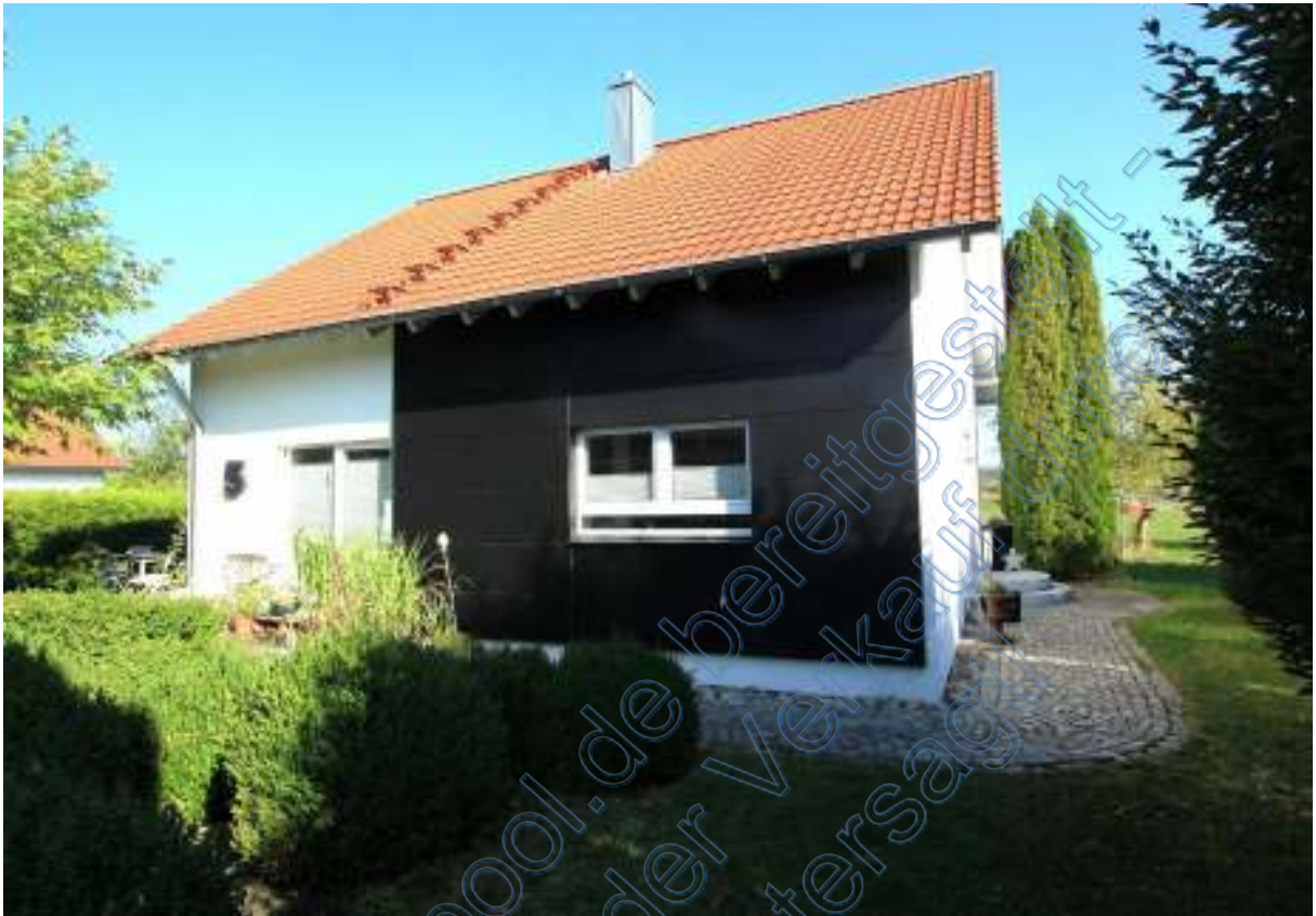
Wohnhaus mit anthraziter Plattenverkleidung und Hauszugang von Süden
