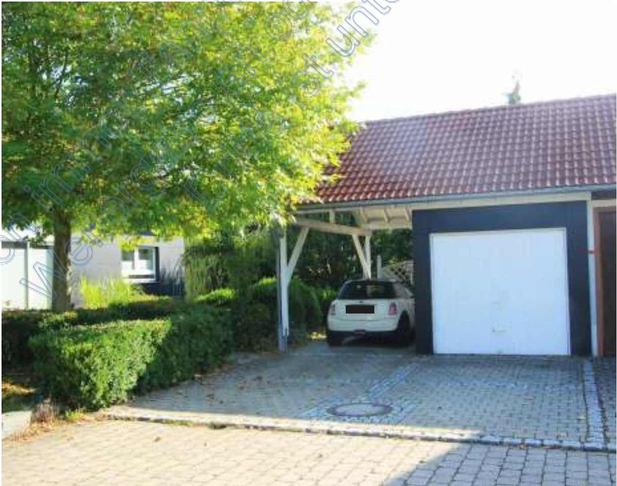
Carport/Garagegebäude mit Zufahrt von Westen
