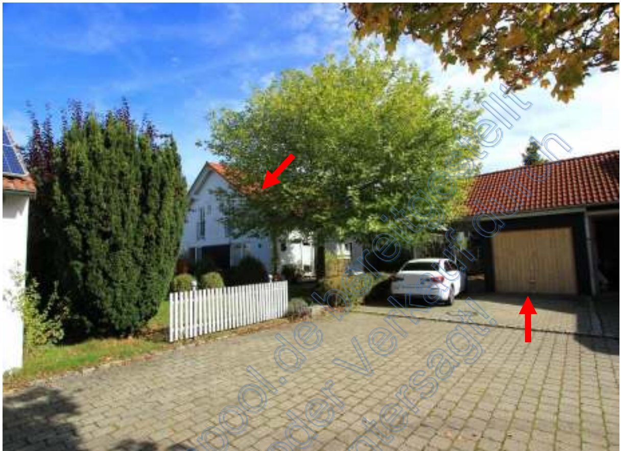
Blick von Südwesten, Pfeile Wohnhaus und Carport/Garagegebäude (rechts)
