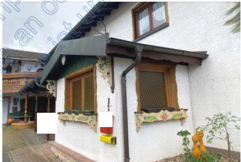
Foto 4 des SV: Eingangsvorbau (Windfang) des vorderen Gebäudeteils
