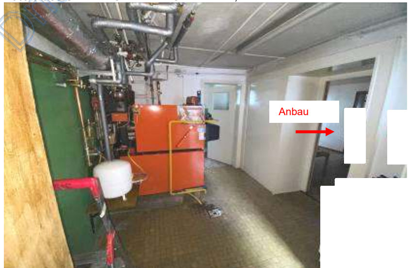
Foto 10 des SV: EG vorderer Gebäudeteil, Heizraum mt Durchgang zum Anbau (hinterer Gebäudeteil)
