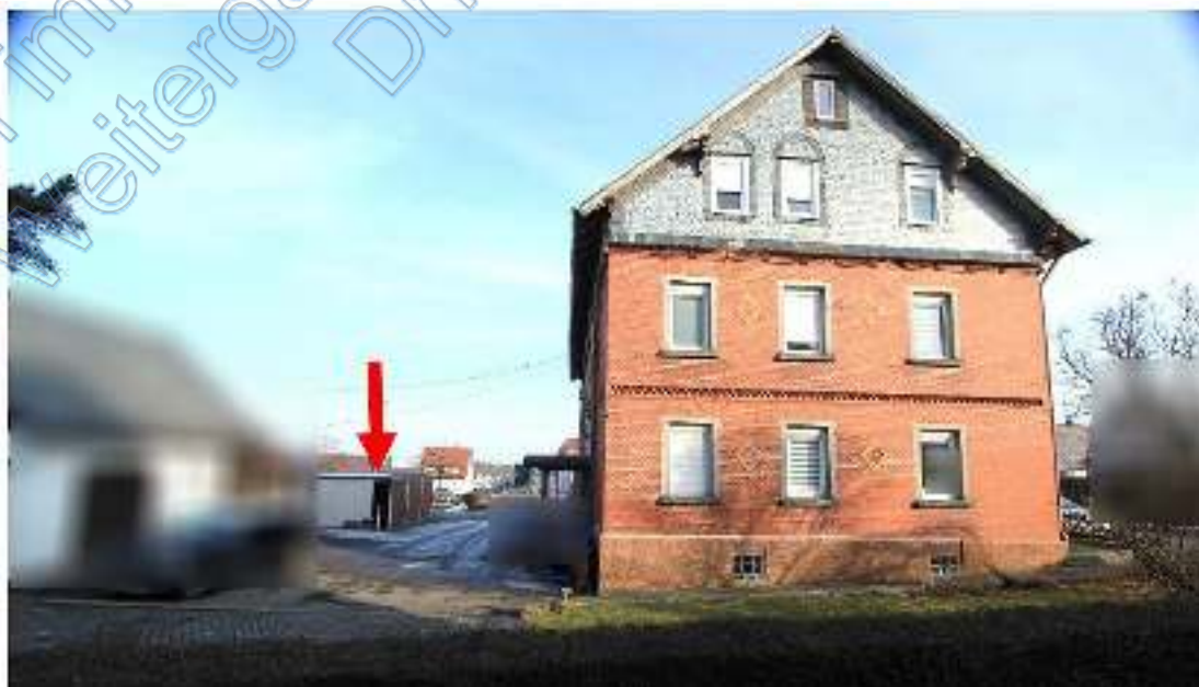
Westgiebelseite Doppelhaus mit Nachbarwohnhaus 41, links Hof, Pfeil Vierergarage
