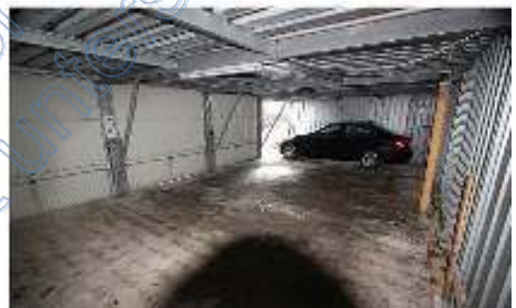
Vierergarage von innen
