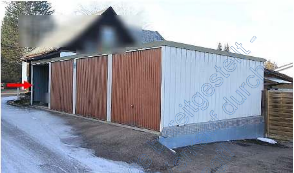
Vierergarage aus Blech von Südosten
