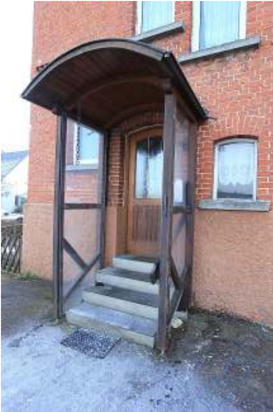
Eingangstreppe mit Umhausung
