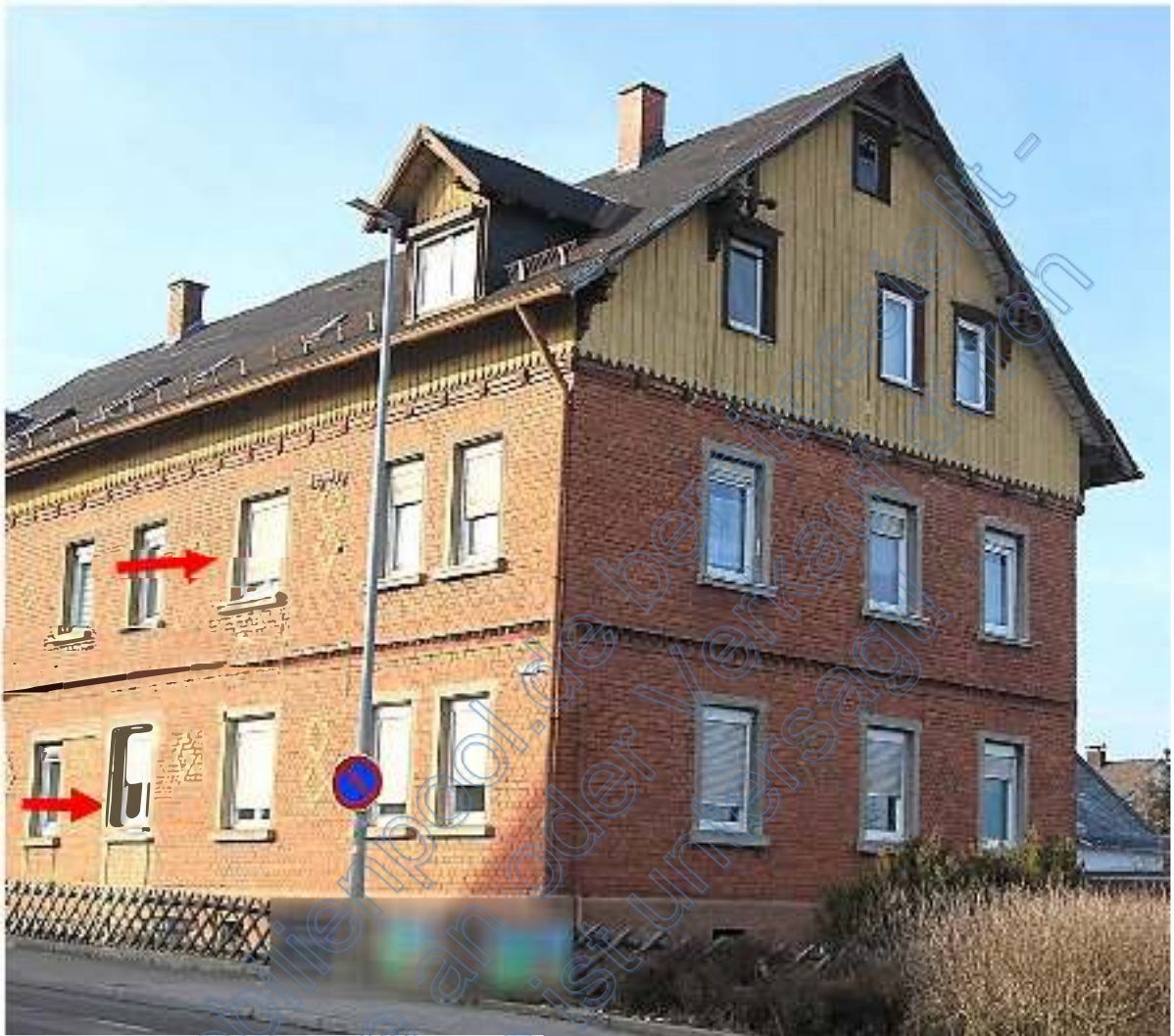
Haushälfte Bahnhofstraße 43 von Südosten
