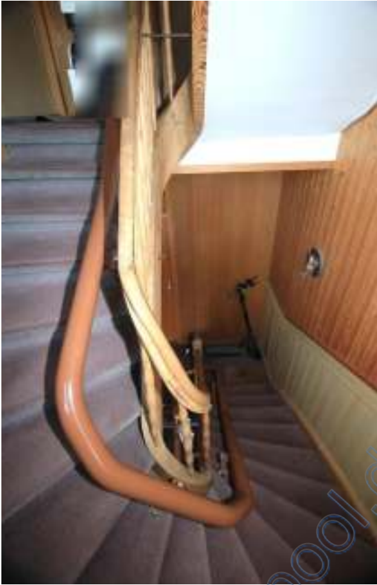
Treppenhaus EG/OG mit Treppenlift
