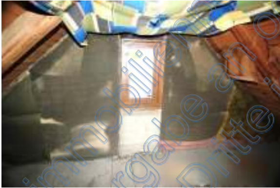
Giebelwand nach Osten
