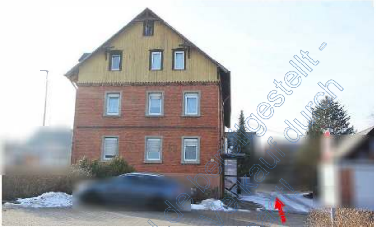
Ostgiebelseite Wohnhaus, Pfeil Wegerecht für Nachbargrundstück
