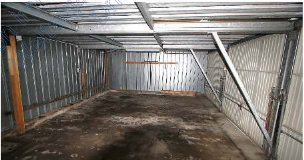
Vierergarage von innen
