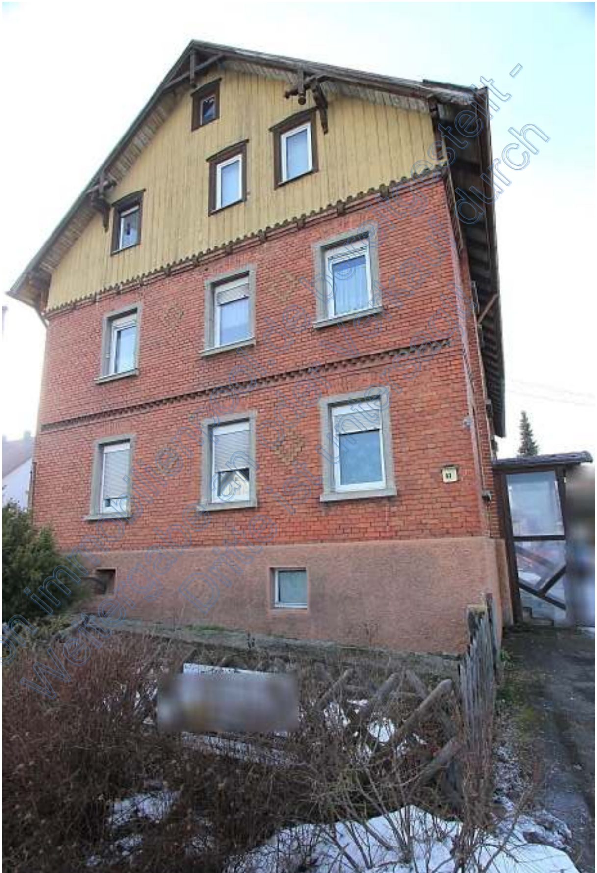
Ostgiebelseite Haushälfte Bahnhofstraße 43, rechts Hauseingang
