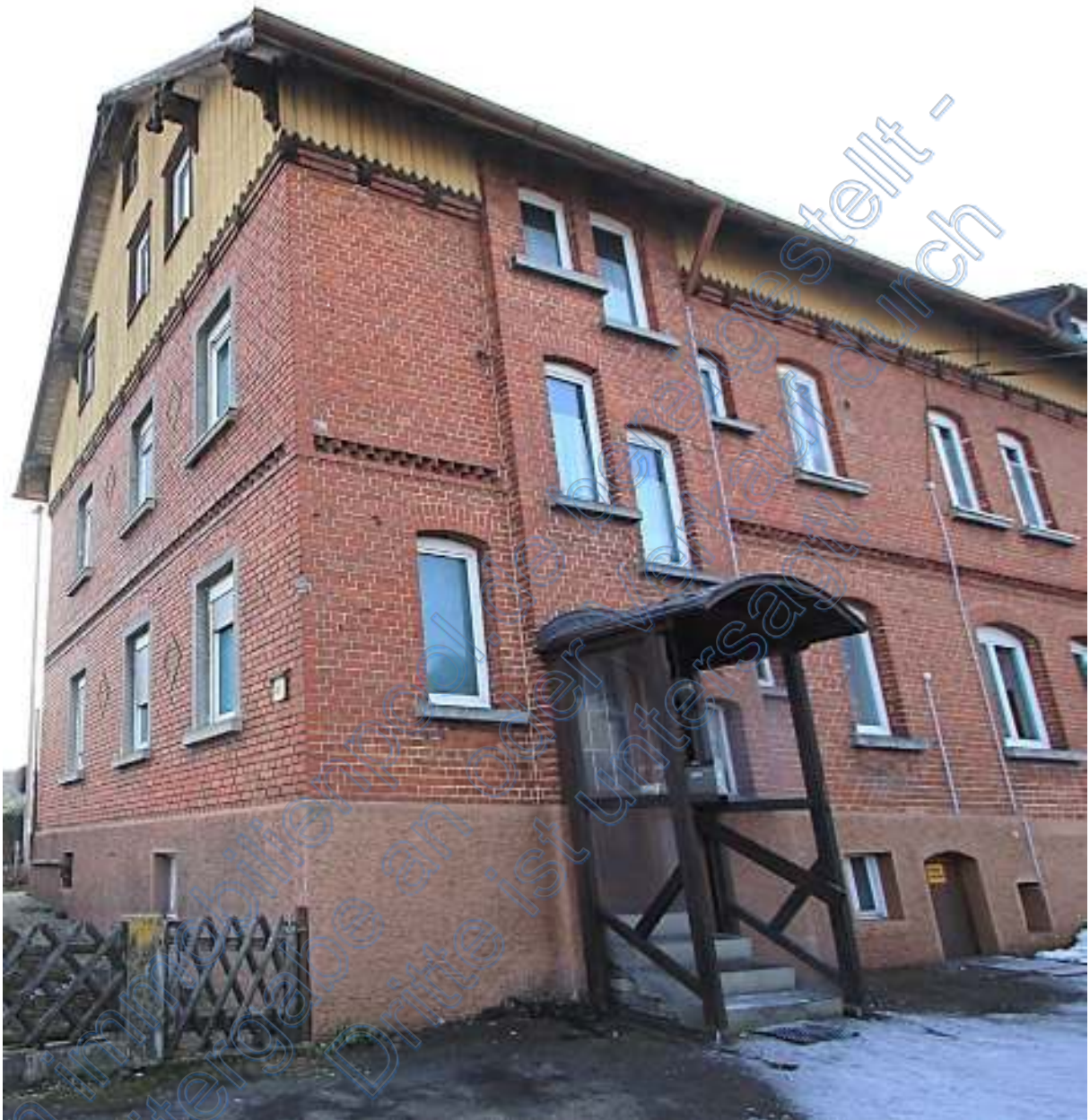
Haushälfte Bahnhofstraße 43 mit Hauseingang von Nordosten
