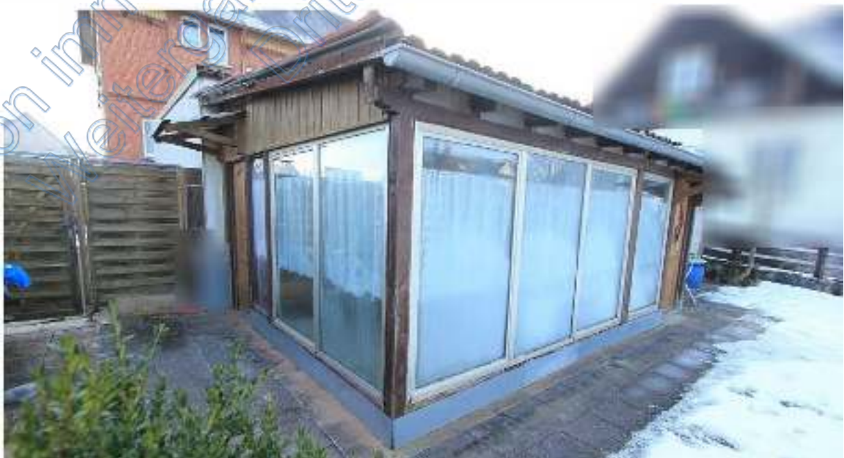
Gartenhaus mit großflächiger Verglasung von Nordosten
