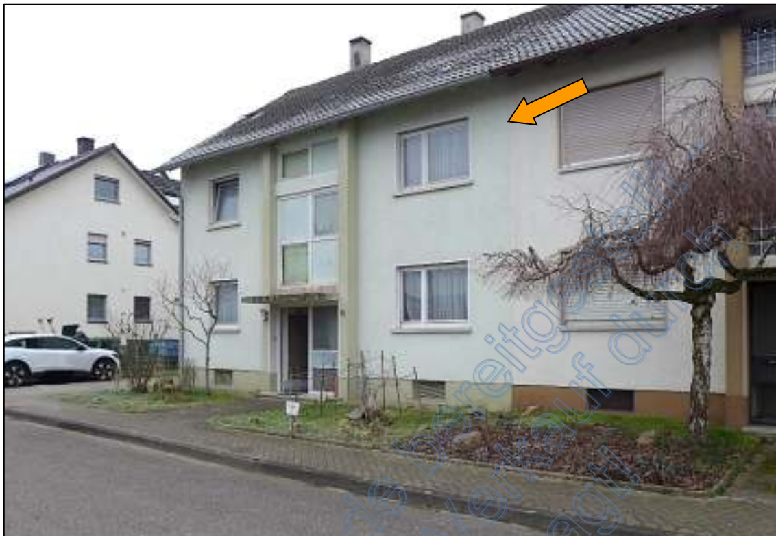
Bild 1 –Blick von Nordosten auf das Haus
