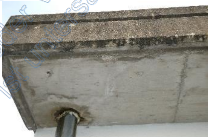
Unteransicht äußeres Garagendach
