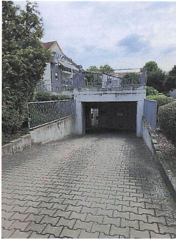
Aufnahme 11: Tiefgaragenzufahrt Am alten Zimmerplatz
