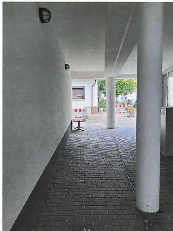
Aufnahme 10: Passage Heidelberger Straße
