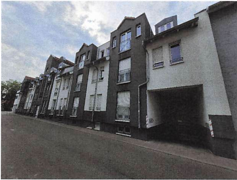
Aufnahme 3: Straßenansicht Nordost
