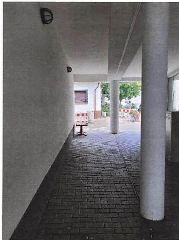
Aufnahme 6: Passage Heidelberger Straße
