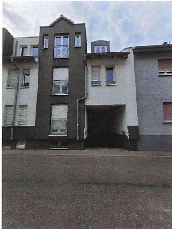
Aufnahme 2: Tiefgaragenzufahrt von der Heidelberger Straße
