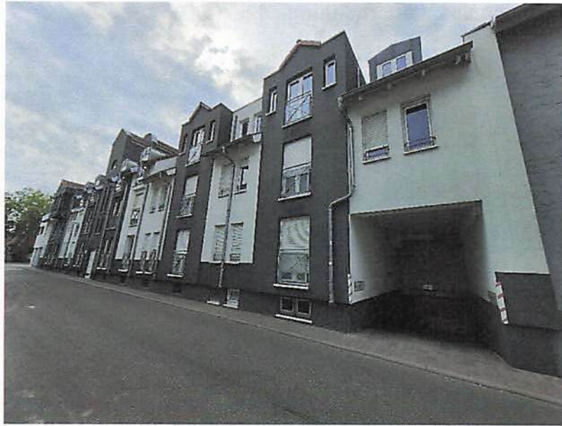
Aufnahme 3: Straßenansicht Nordost
