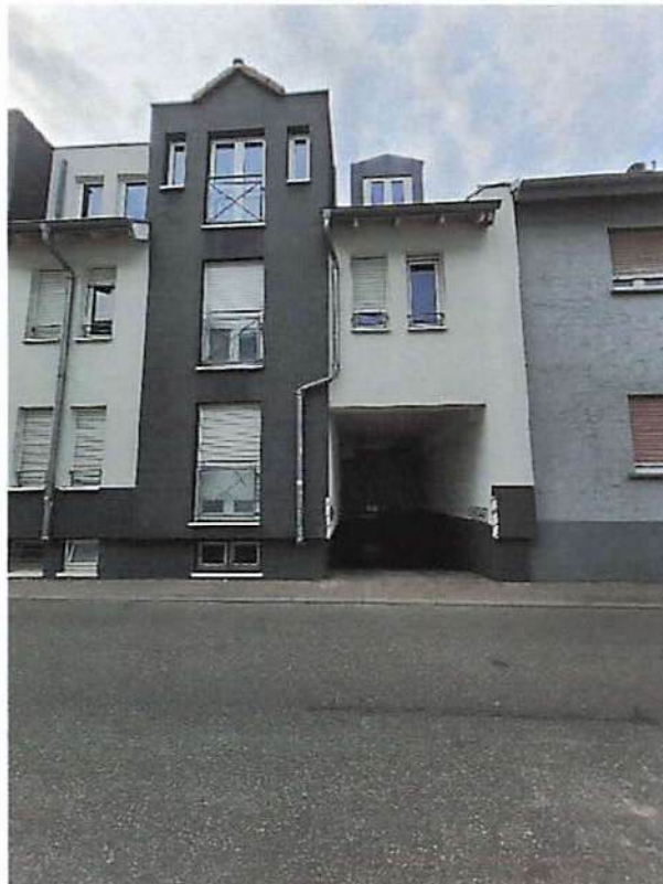
Aufnahme 2: Tiefgaragenzufahrt von der Heidelberger Straße
