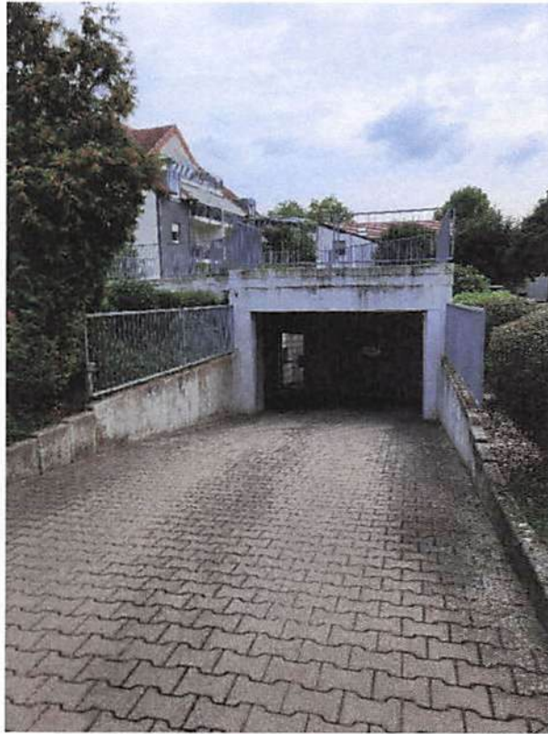
Aufnahme 7: Tiefgaragenzufahrt Am alten Zimmerplatz
